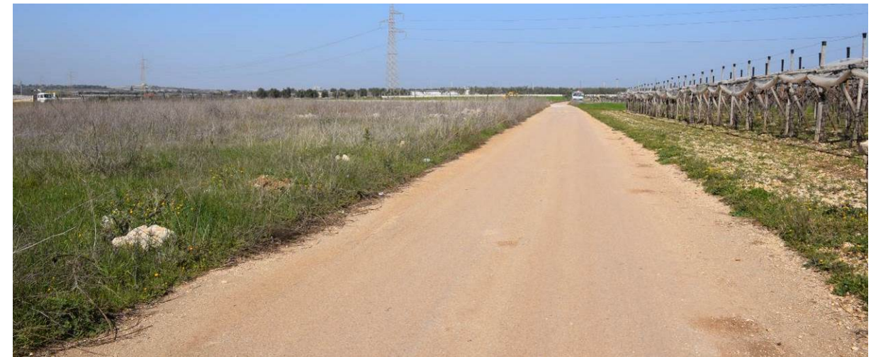
Figura 16: la strada asfaltata nei pressi dell'aerogeneratore A04, generalmente idonea ai trasporti. La strada sarà percorsa anche dal cavidotto interrato.
