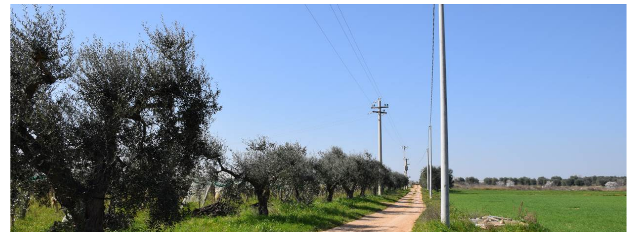
Figura 12: la strada senza denominazione di accesso all'aerogeneratore A02 che ha necessità di allargamenti della carreggiata. La strada sarà percorsa anche dal cavidotto interrato.
