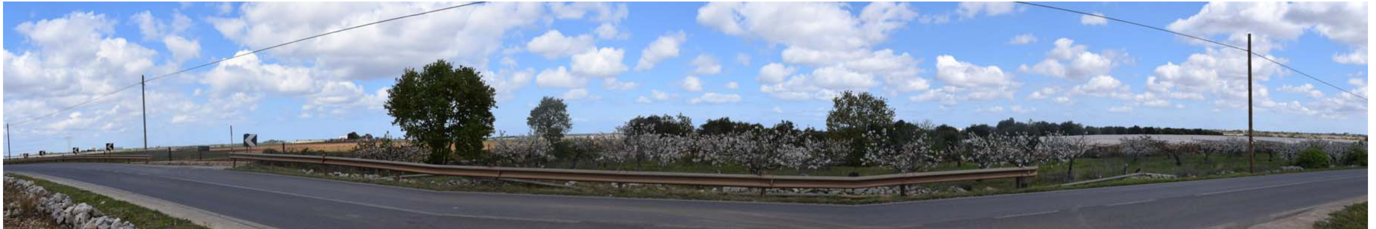
Panoramica 21 - SP 172 – STATO DI FATTO
