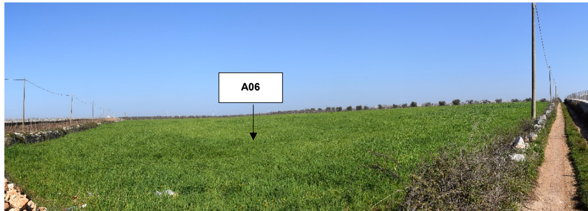
Figura 20: la freccia indica la posizione dell'aerogeneratore A06.
