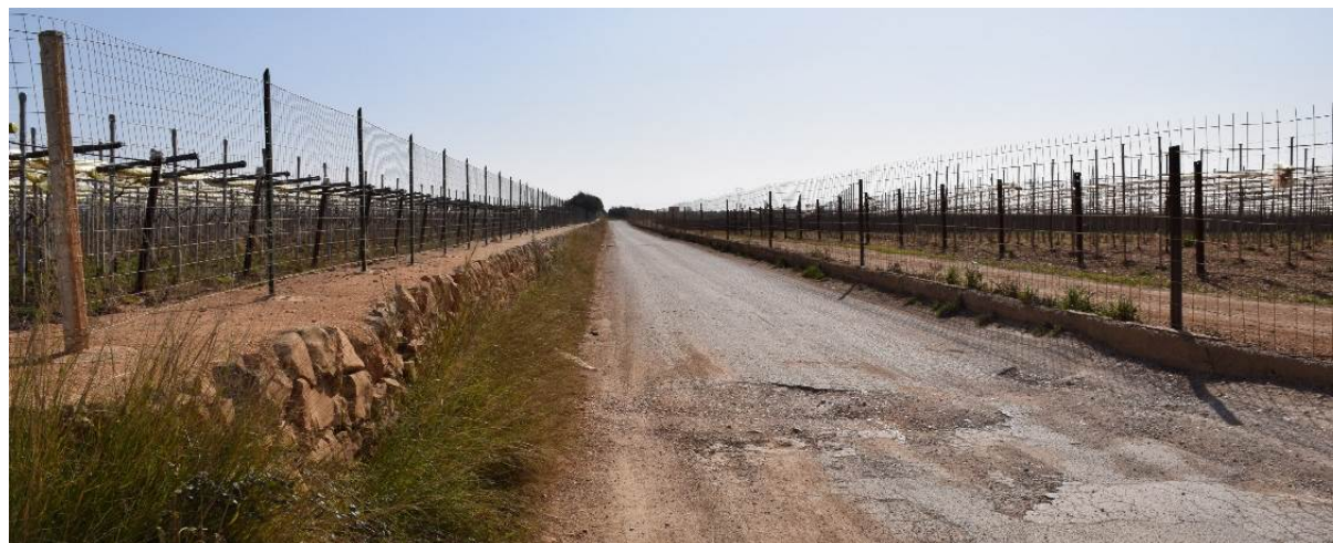
Figura 21: strada vicinale Tarantina nei pressi dell'accesso all'aerogeneratore A06. La strada è generalmente idonea per il transito dei mezzi: vi è la necessità di piccoli interventi di adeguamento del piano viario e di puntuali allargamenti della carreggiata. La strada sarà percorsa anche dal cavidotto interrato.
