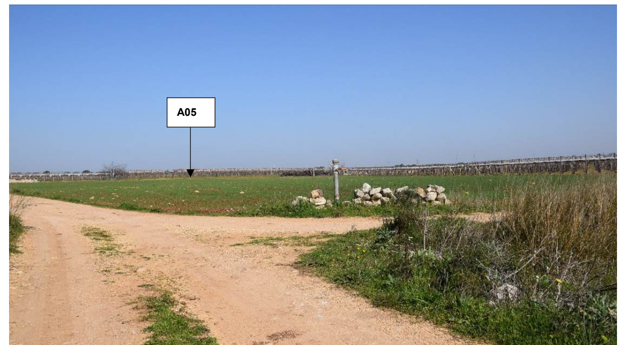
Figura 18: la freccia indica la posizione dell'aerogeneratore A05 nel fondo destinato a seminativo. La strada interpoderali in massciata e finitura in stabilizzato da cui si serve l'aerogeneratore è sostanzialmente adeguata.
