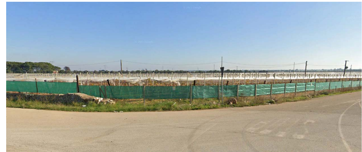
Figura 27: Area di ubicazione della Stazione elettrica RTN 380 kV di Terna SpA e relativi raccordi alla linea 380 kV “Andria – Brindisi Sud ST” (località Patalino).
