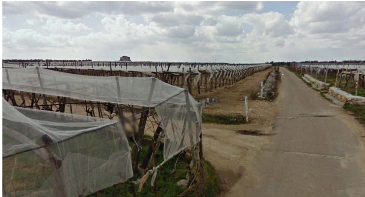
Figura 19: imbocco della strada interpodereale in massiciata e finitura in stabilizzato da cui si serve l'aerogeneratore A05, vista dalla strada asfaltata; l'imbocco dovrà essere allargato per consentire il transito dei mezzi di trasporto delle strutture. La strada sarà percorsa anche dal cavidotto interrato.
