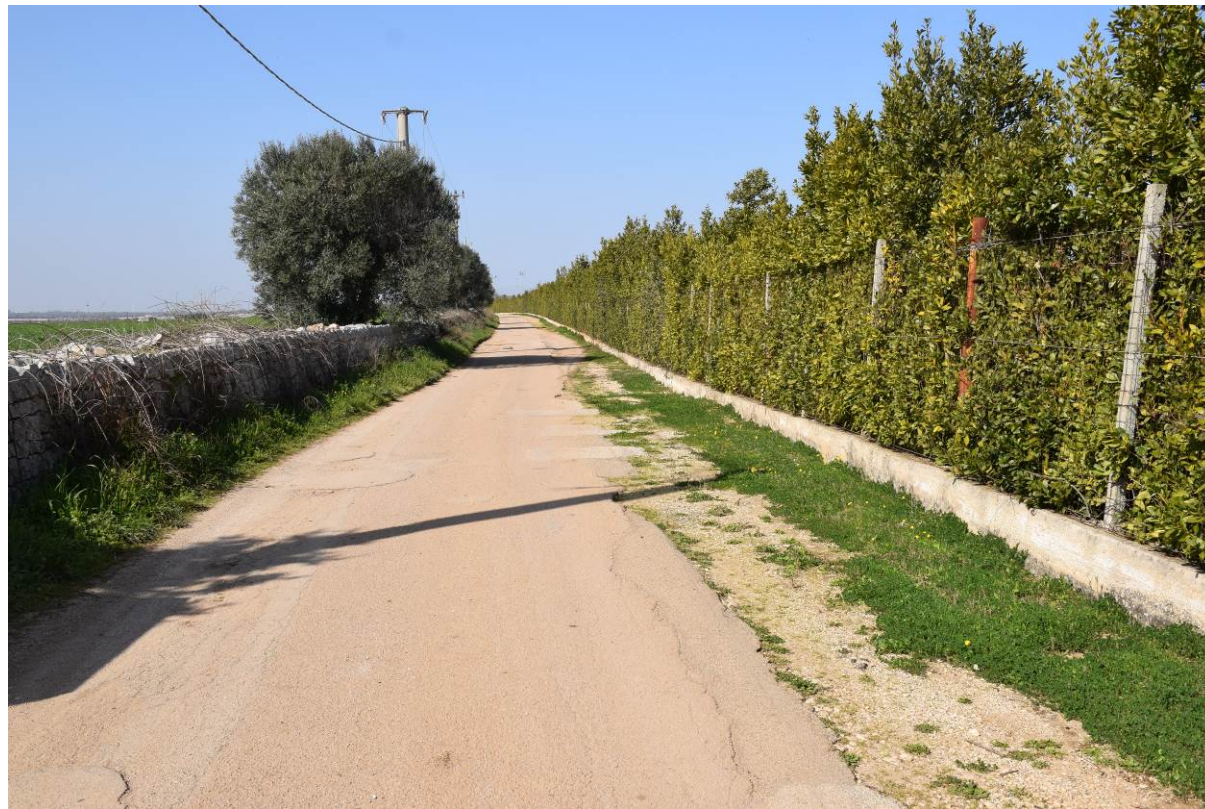
Figura 24: la strada comunale da Turi a Cellamare: sono necessari puntuali allargamenti della carreggiata o temporanei spostamenti delle recinzioni dei campi.
