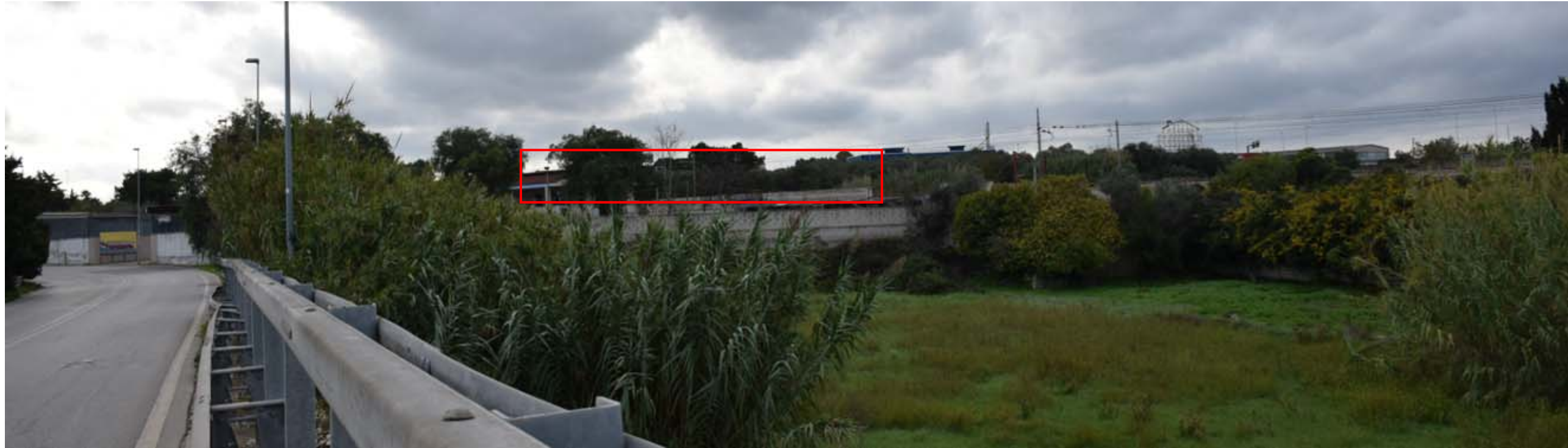
Panoramica 11– dalla località costiera Cala San Giorgio.
