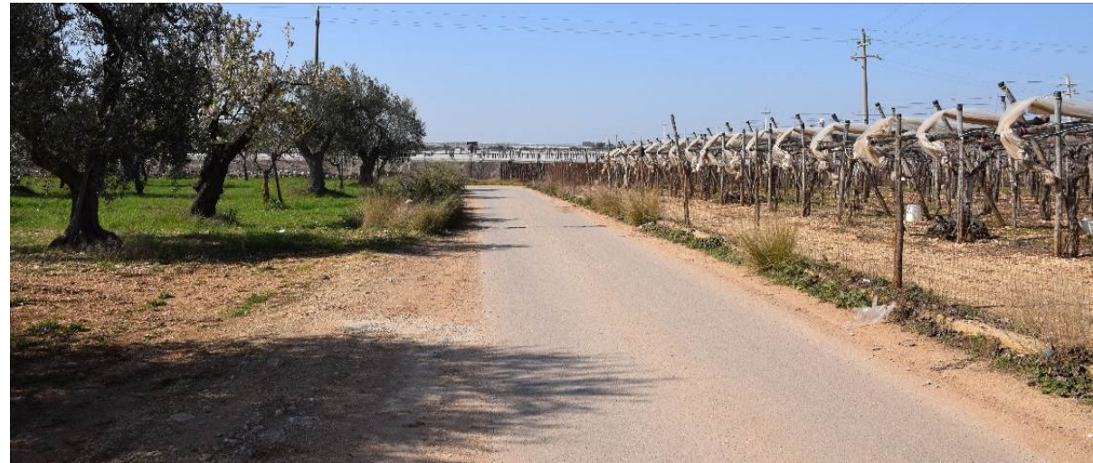
Figura 14: la strada asfaltata nei pressi dell'aerogeneratore A03, generalmente idonea ai trasporti. La strada sarà percorsa anche dal cavidotto interrato.
