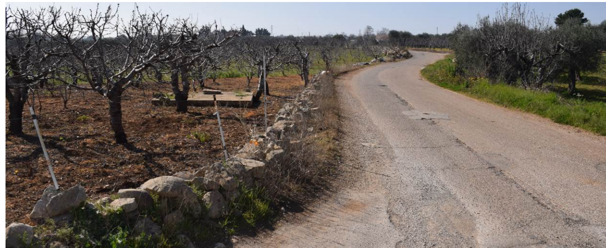
Figura 8: tratto della SP179 in prossimità dell'imbocco della strada comunale Guidotti di accesso alla A01
