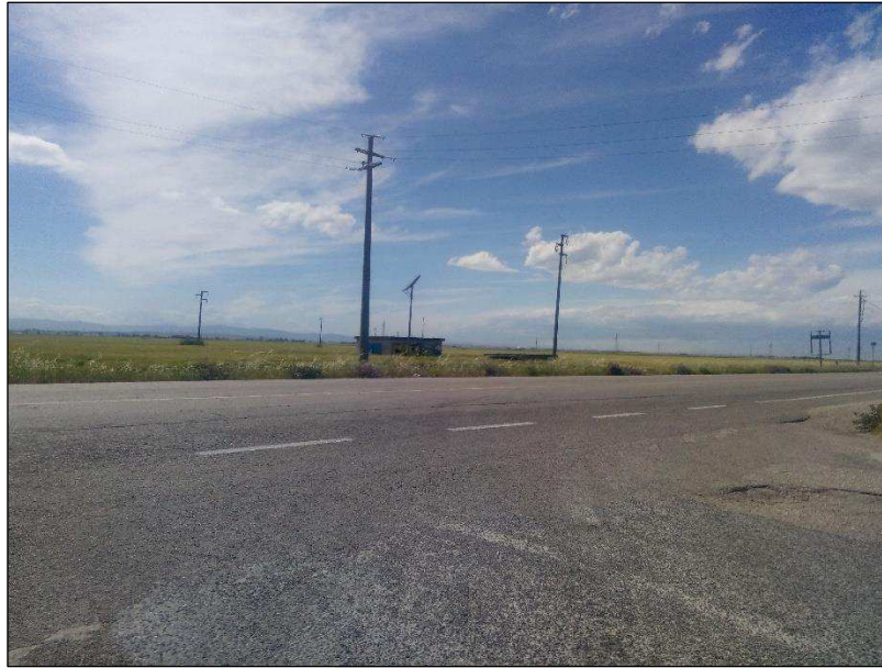
Foto. 10 – SS16 Vista sud ovest area impianto
