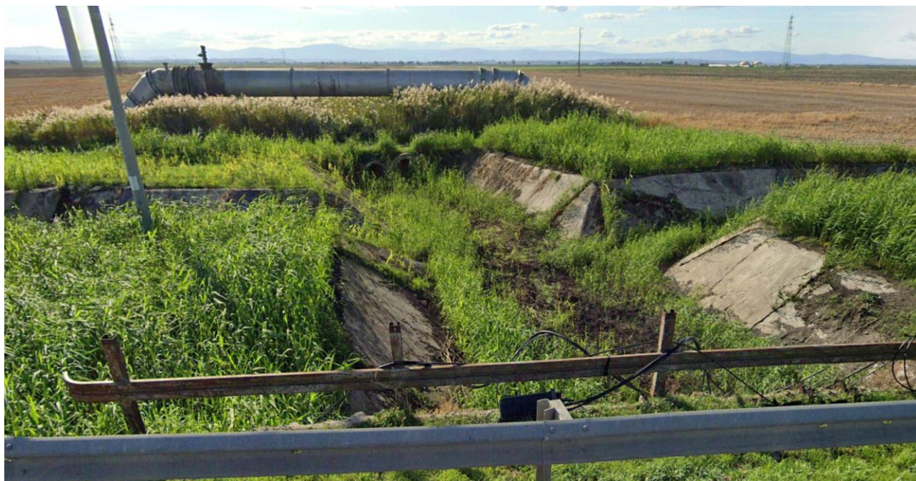
Figura 4-2: Alveo del Torrente Laccio in prossimità dell'impianto
