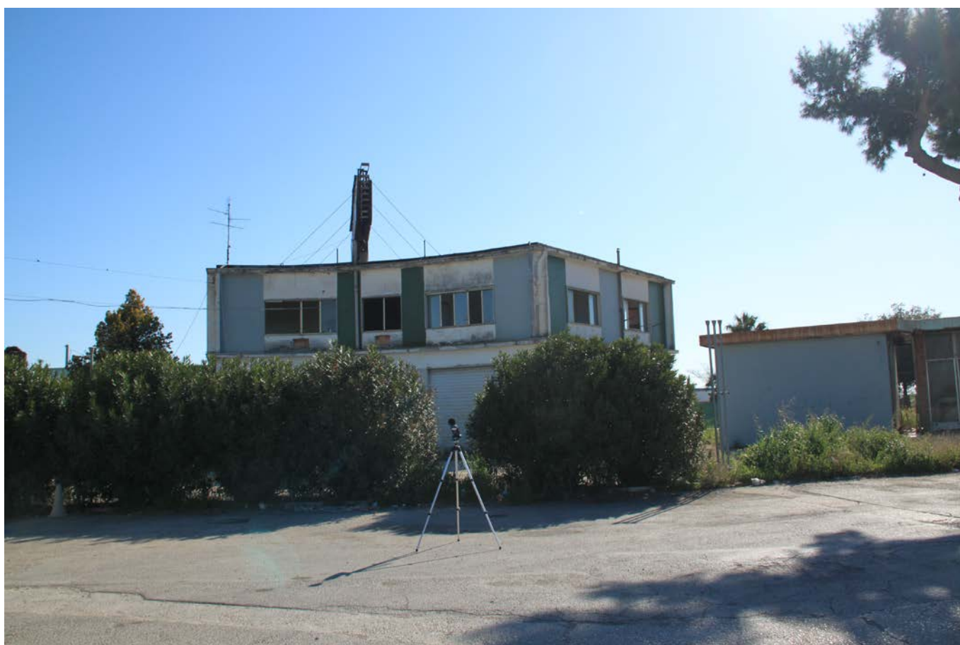
POSTAZIONE DI MISURA
