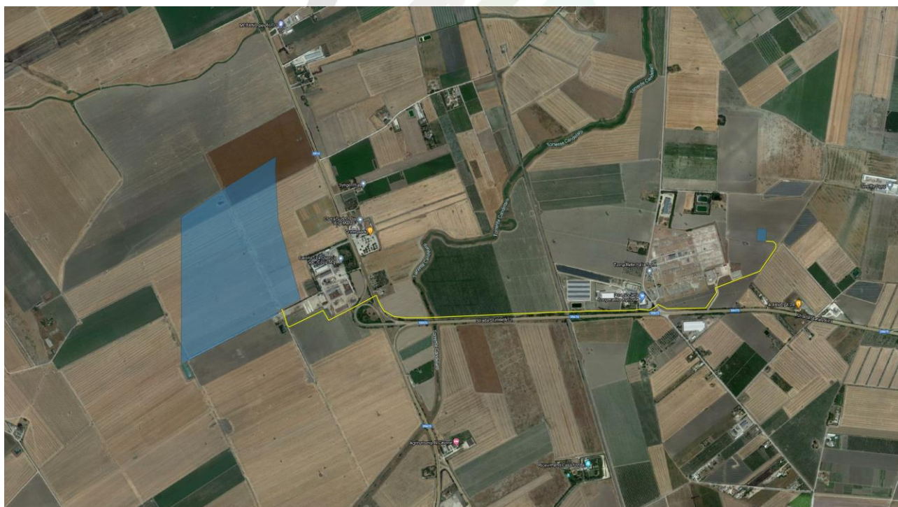
Figura 2-1: Aree Protette EUAP, in blu la perimetrazione dell'impianto, in giallo il tracciato della connessione
