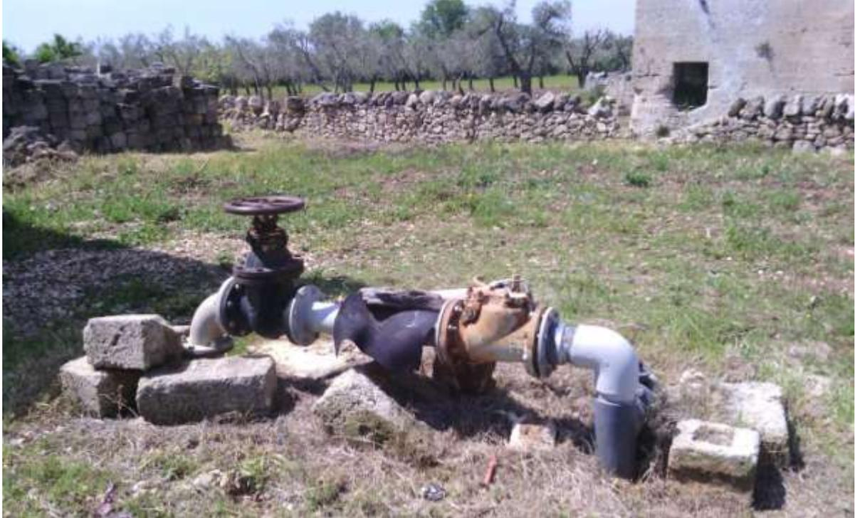
**Figura 6: Porzione di condotta interrata visibile fuori terra.**
