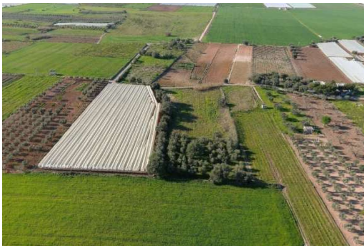
Foto 04 – Area impianto verso confine sud vista dall'alto
