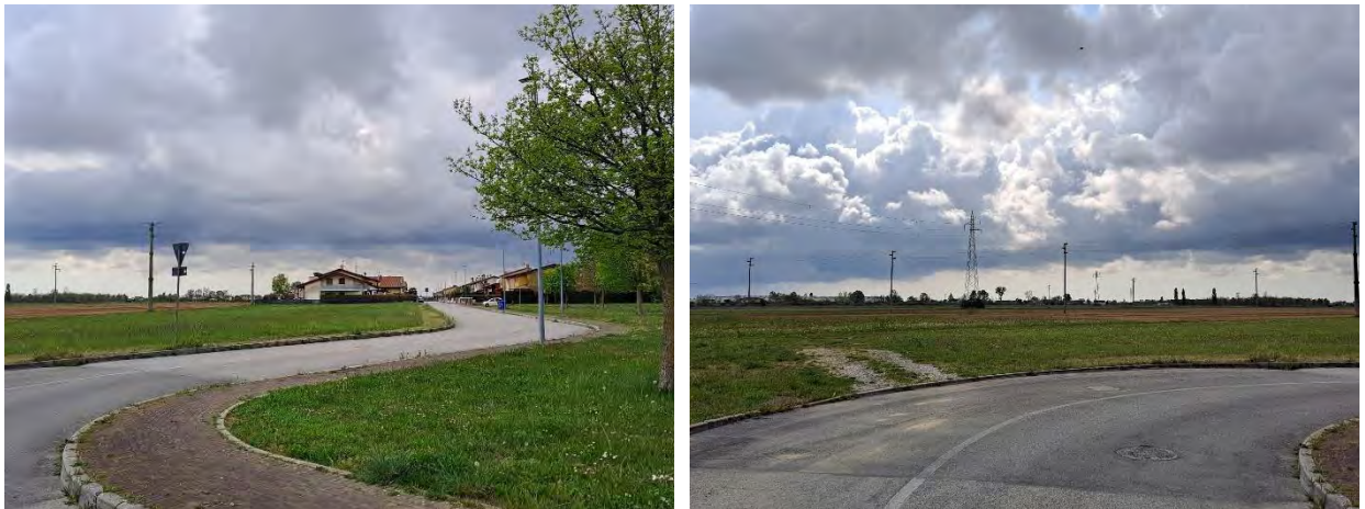
Figura 5-9 – Via Arrio e ingresso in fase di cantiere
