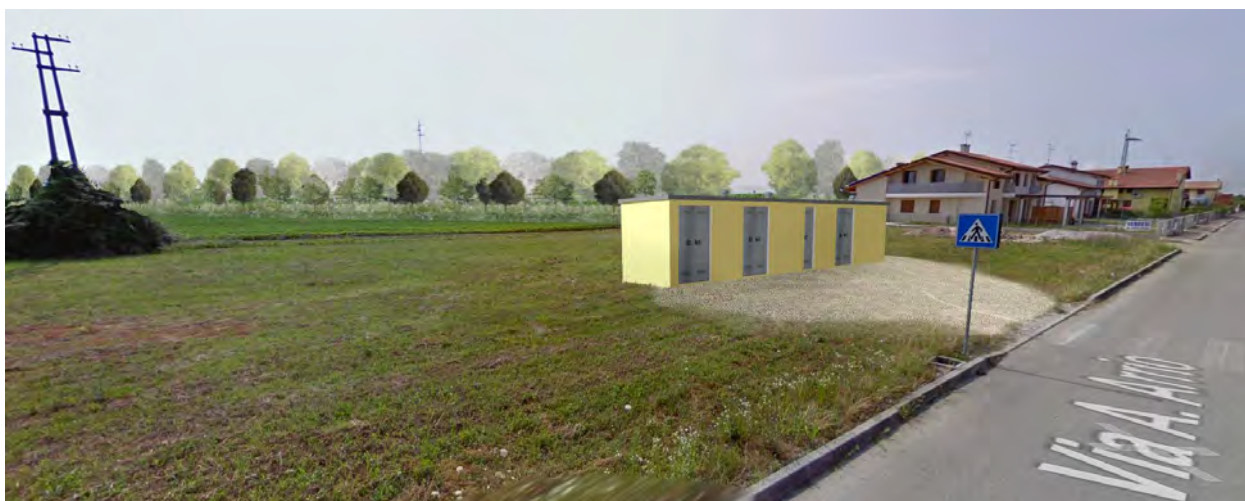
Figura 7-42 – Vista della zona cabina MT/BT da via Arrio – Post Operam
