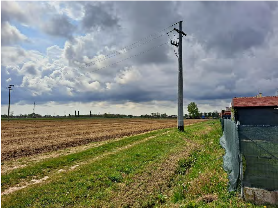
Figura 7-33 – Vista P3 ante operam
