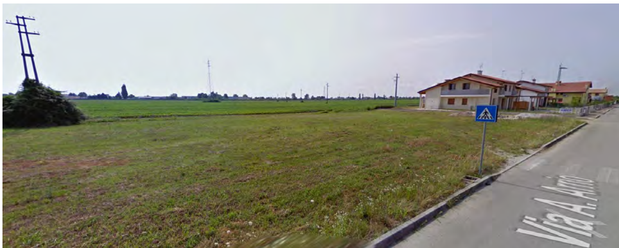
Figura 7-41 – Vista della zona cabina MT/BT da via Arrio – Ante Operam
