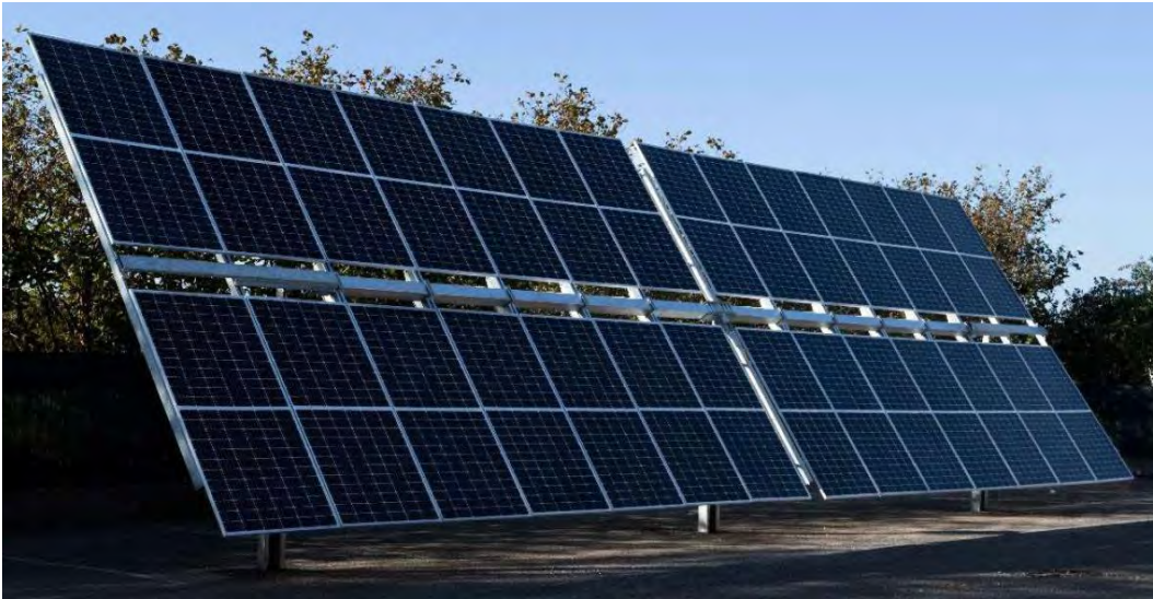
Figura 7-26 – Allestimento dei pannelli su struttura tracker
