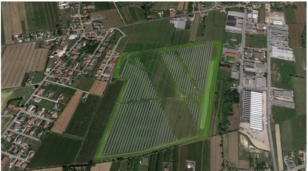
Figura 8-4 – Vista dall'alto – Post Operam
