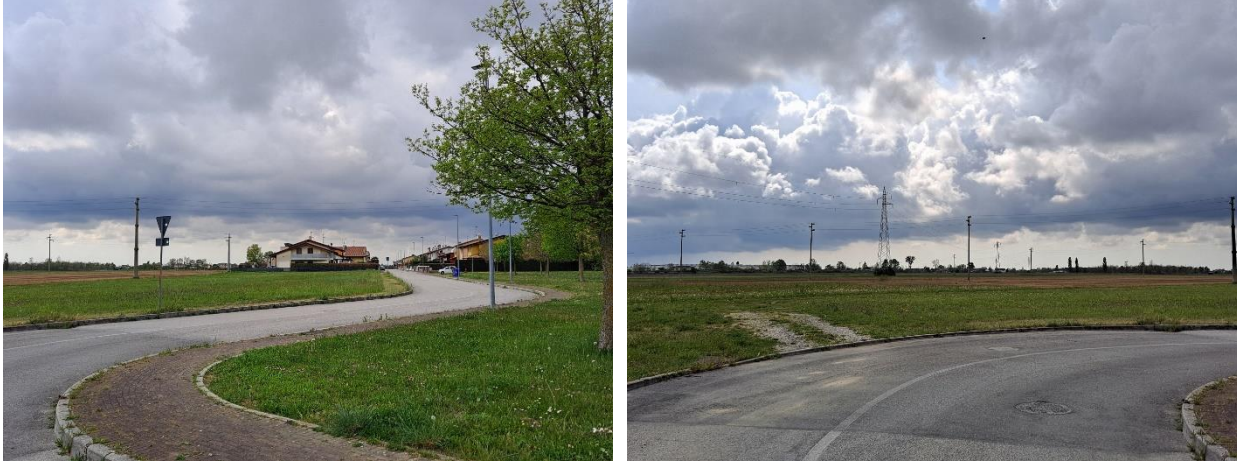
Figura 7-9 – Via Arrio e ingresso in fase di cantiere
