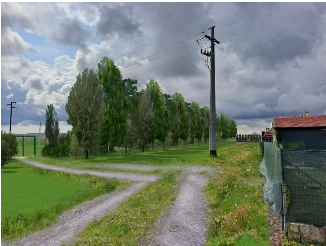
Figura 9-3 – Vista post operam area di ingresso
