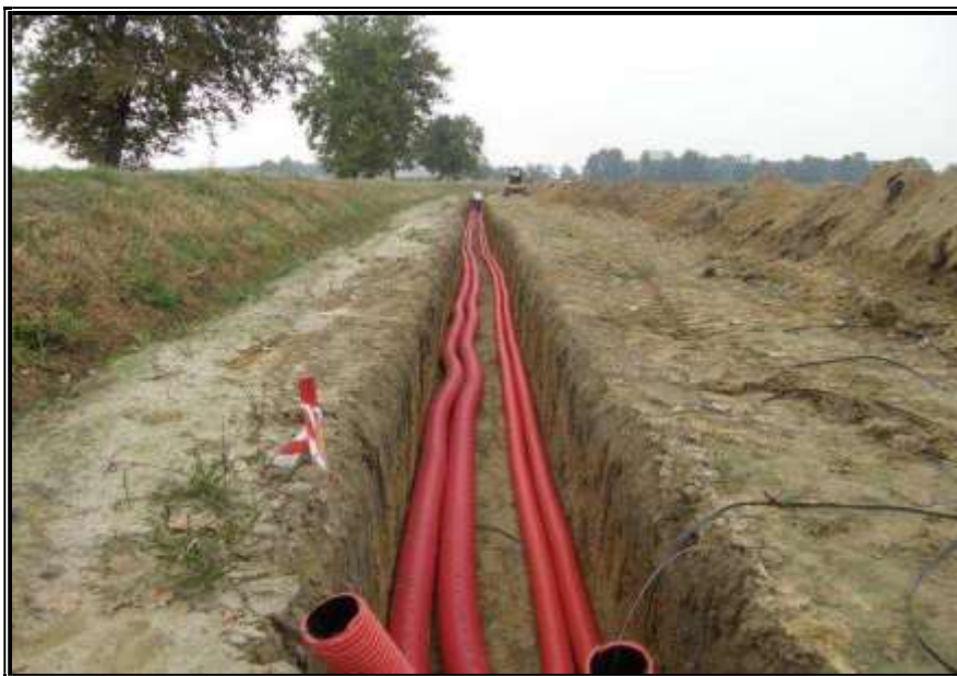
figura n. 7 – Alcune fasi relative per la costruzione dell’impianto
