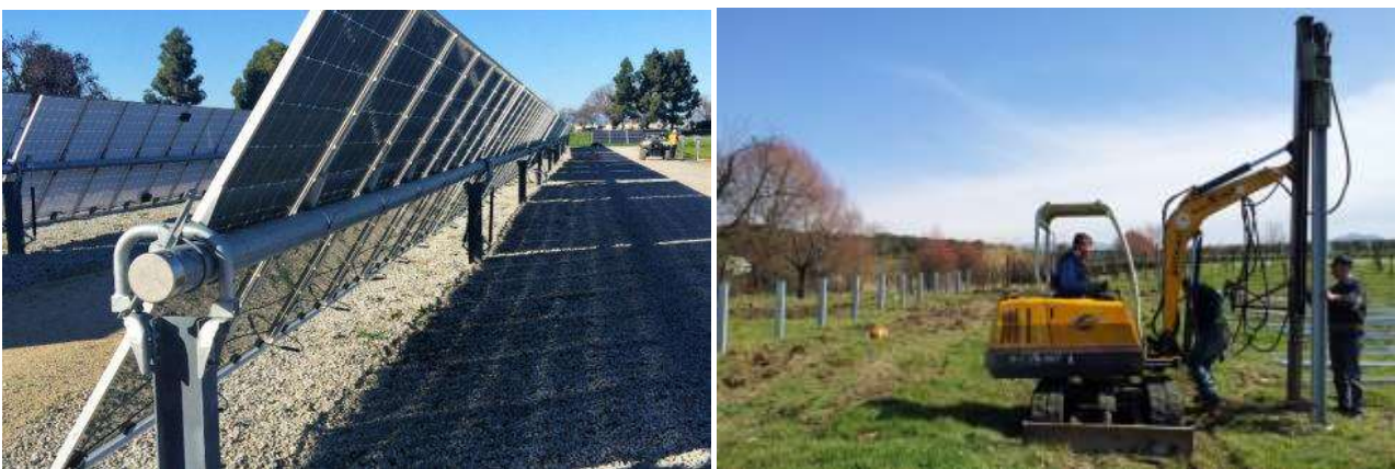
Figura 1 – Esempio di posa delle strutture portanti
