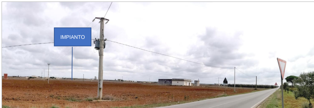
Figura 3-4: Panoramica dalla SP18 in prossimità del viale di accesso di Masseria Monaci – Area impianto
