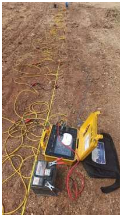
FOTO 5: postazione di energizzazione SS5
