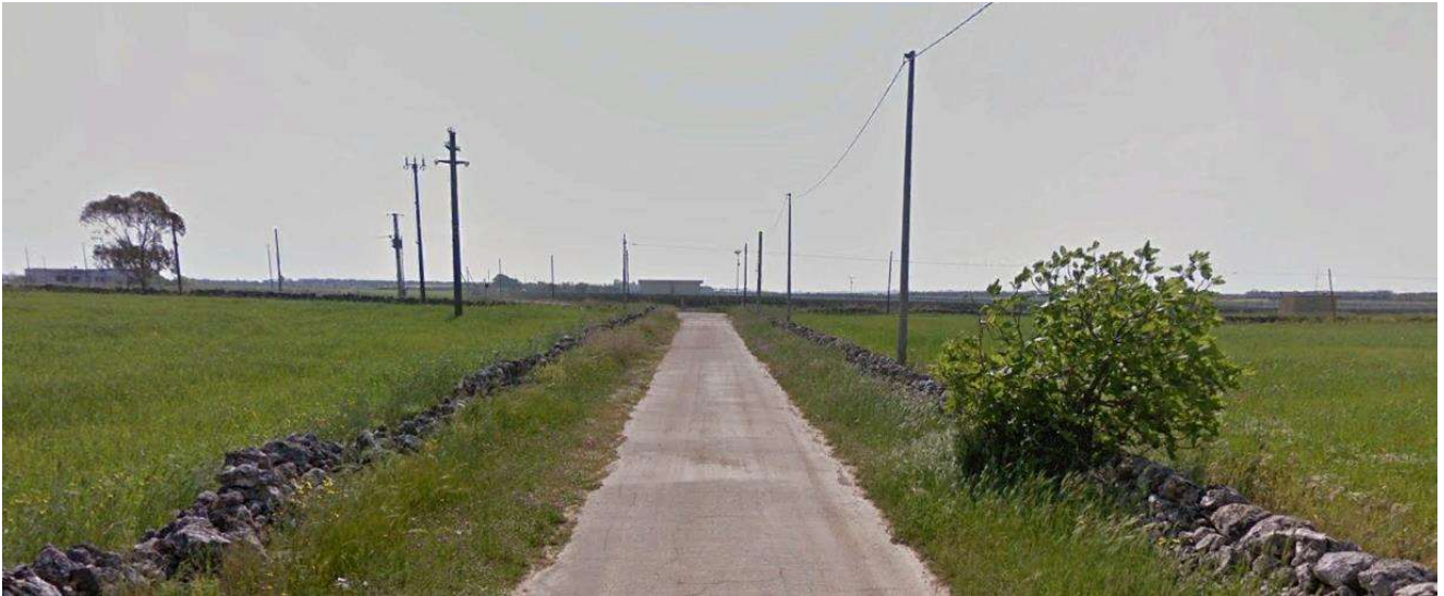
Figura 6-2: Strada interpodereale tra i sottocampi
