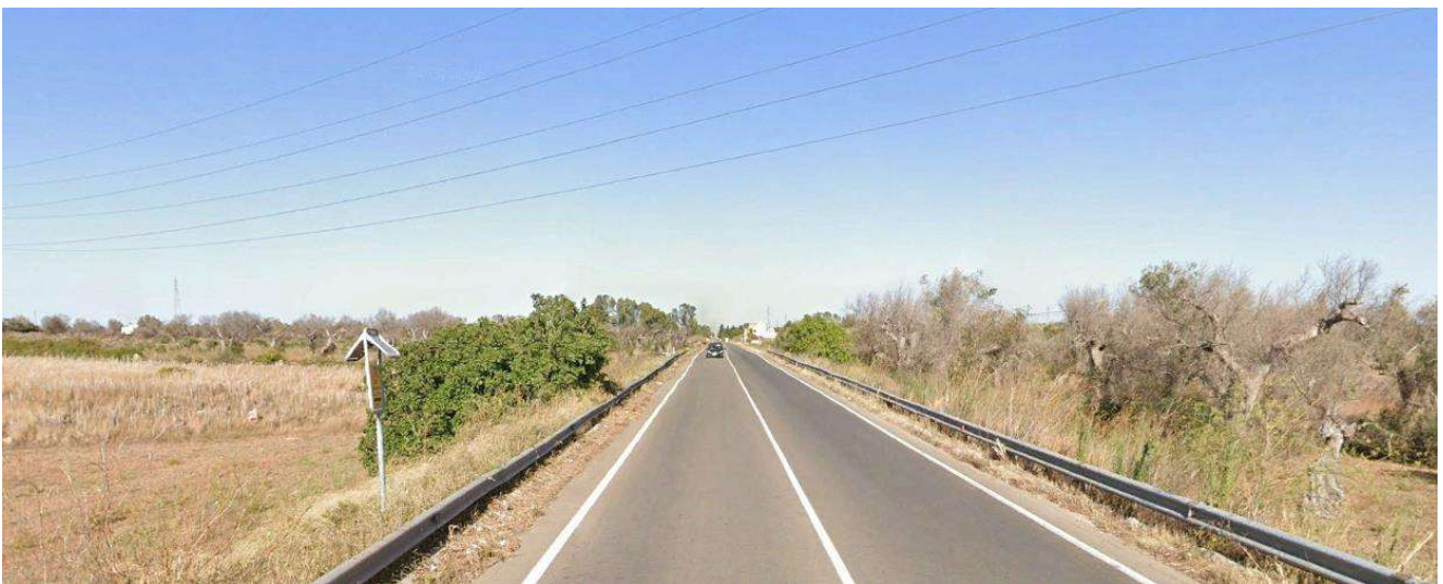
Figura 6-3: Strada SP47 in prossimità della stazione elettrica Galatina
