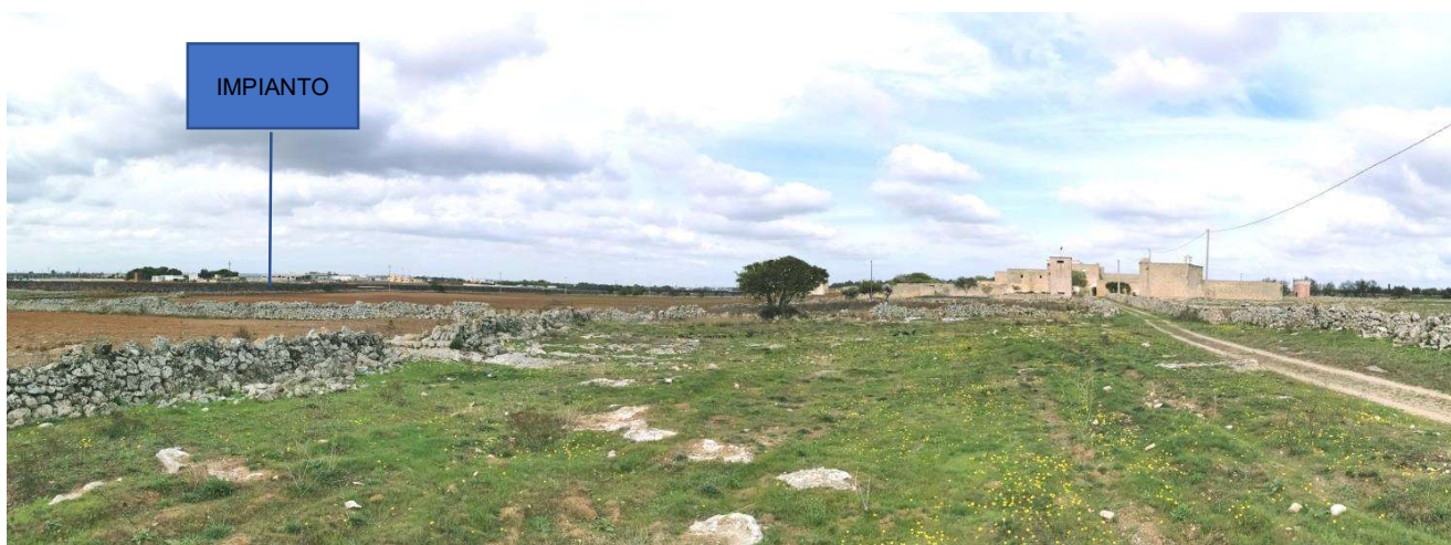
Panoramica dal Punto 02 – post operam
