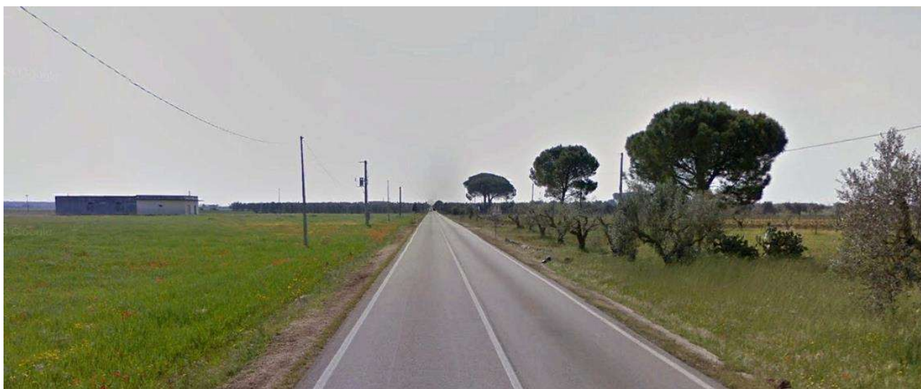
Figura 6-1: Strada Provinciale SP18 in prossimità dell'impianto
