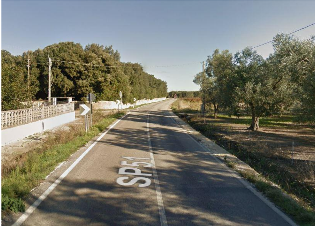
Foto 17 Posizionamento cavidotto lungo la SP 51
