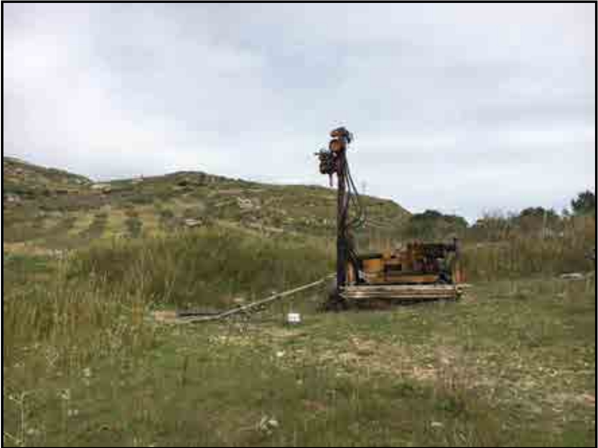
Postazione sondaggio S10
