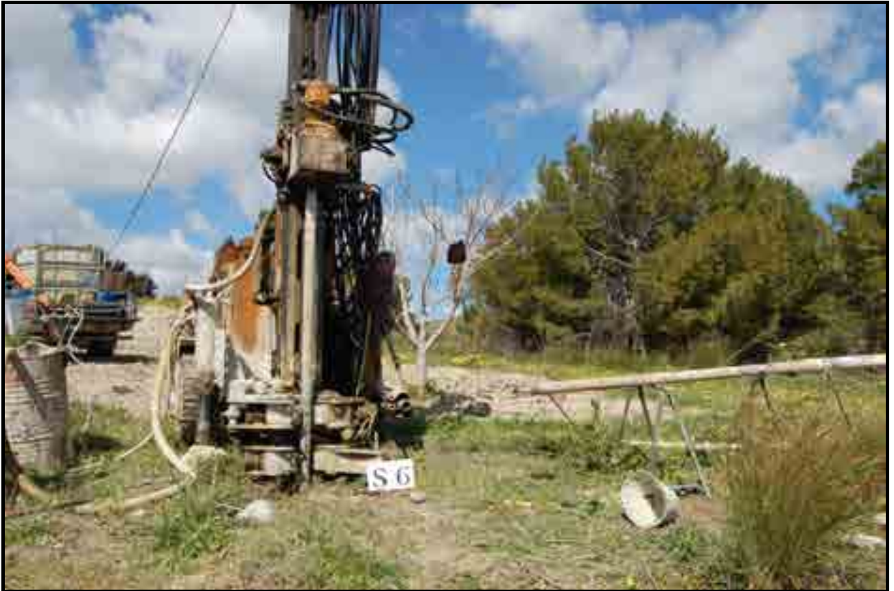
Postazione sondaggio S6
