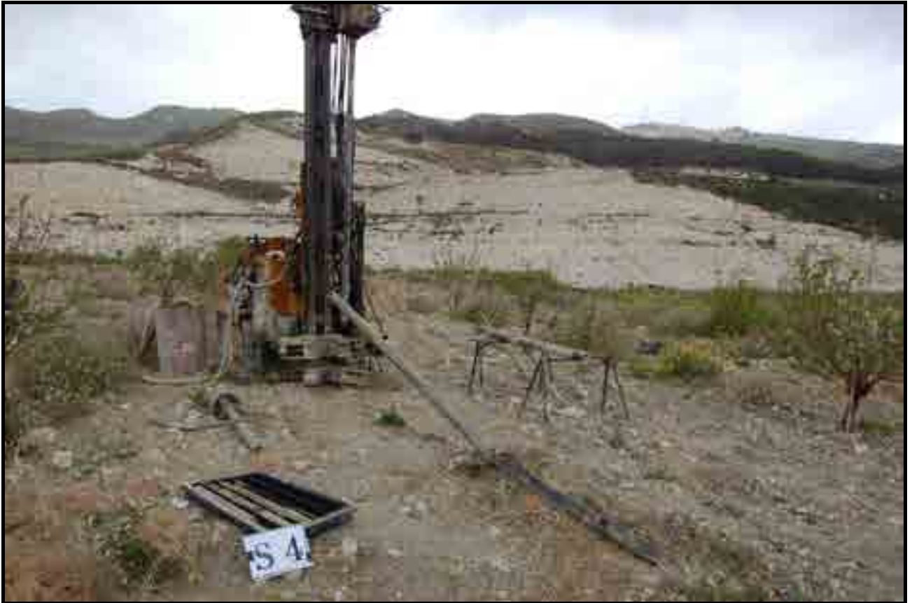
Postazione sondaggio S4
