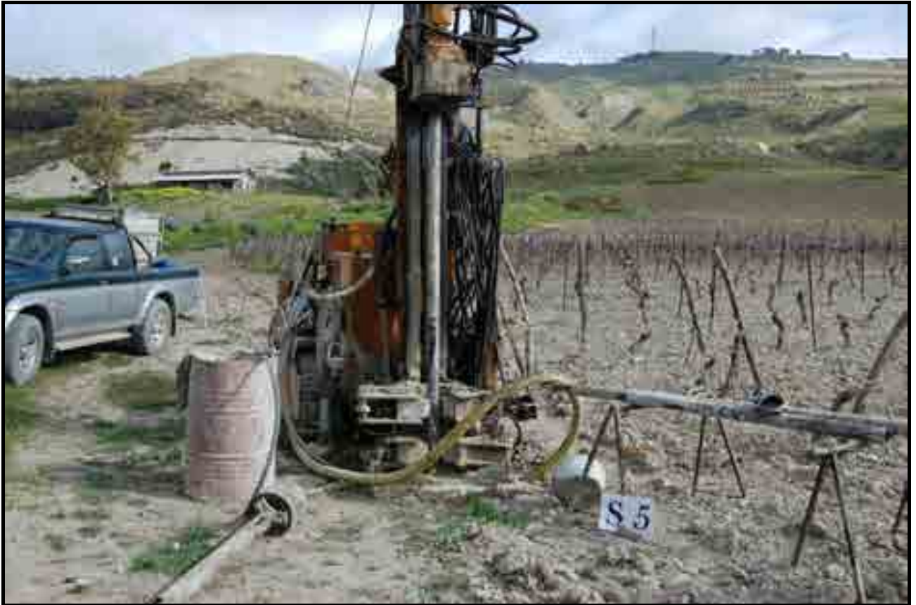
Postazione sondaggio S5
