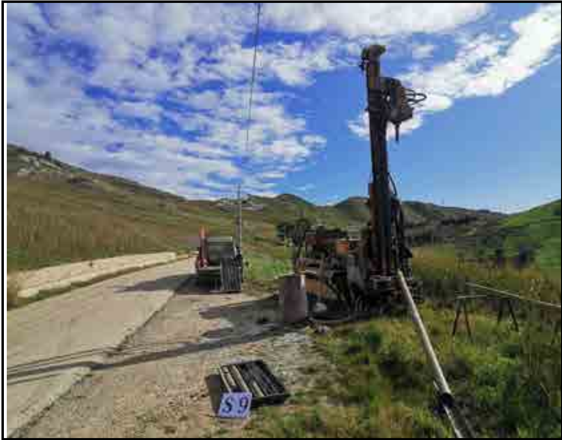
Postazione sondaggio S9
