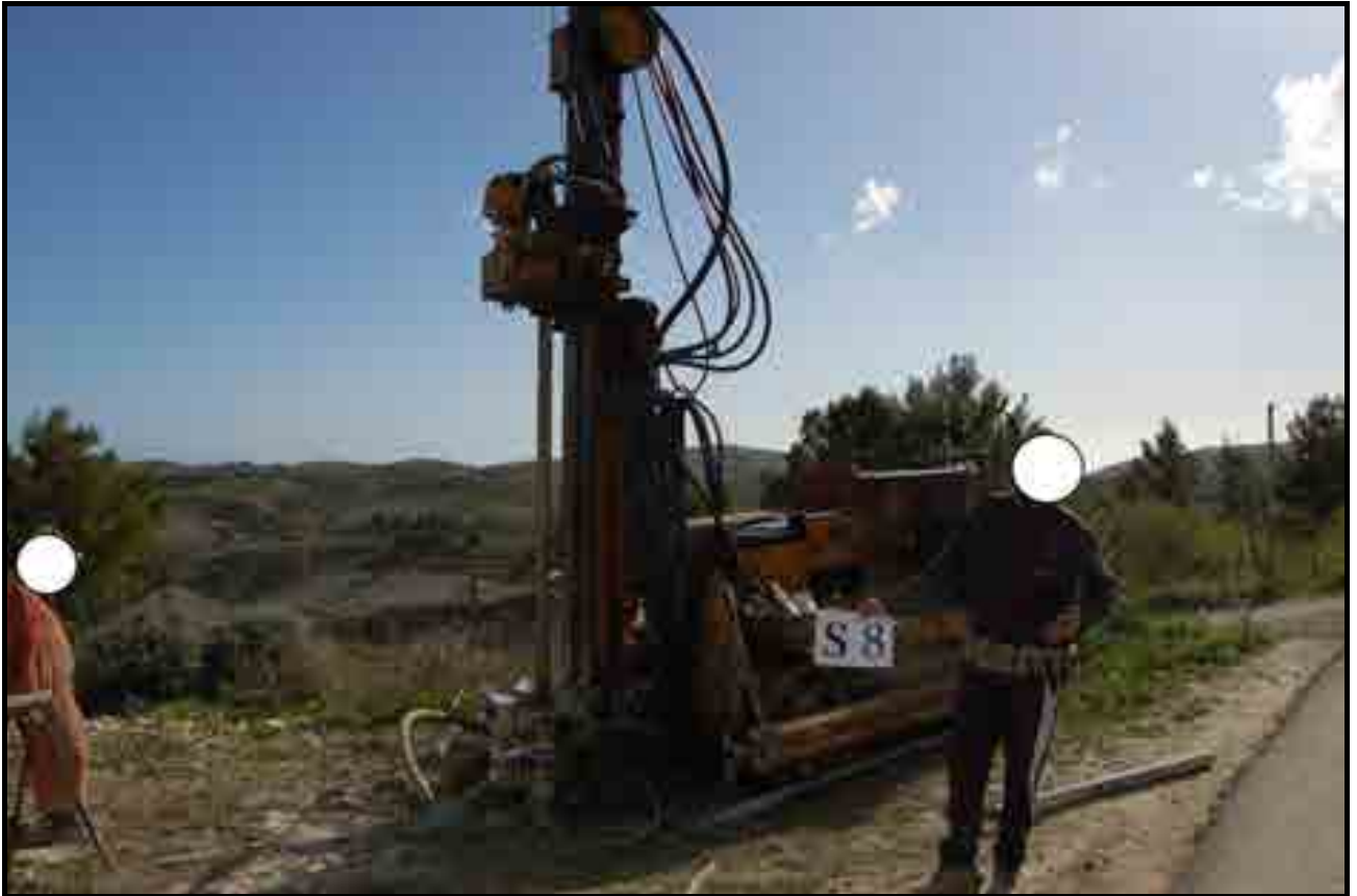
Postazione sondaggio S8
