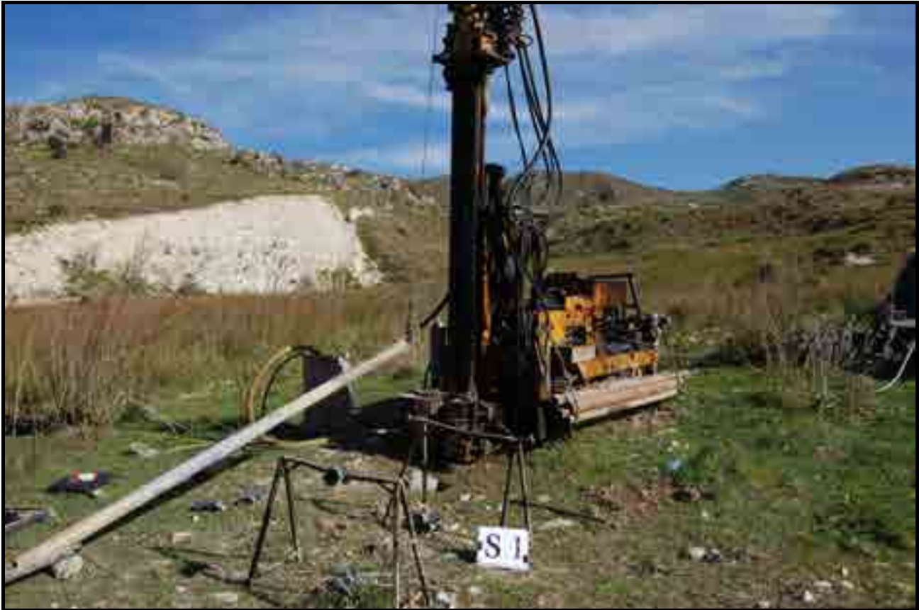
Postazione sondaggio S1
