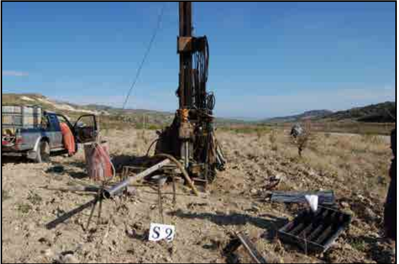
Postazione sondaggio S2
