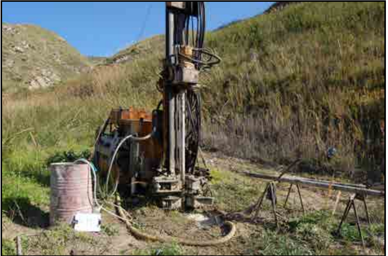
Postazione sondaggio S11
