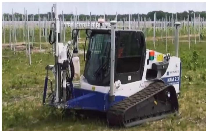
*Figura 14. Esempio di fissaggio delle strutture di supporto*
