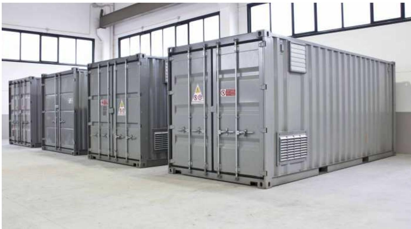
*Figura 16. Esempio di cabina container prefabbricata*
