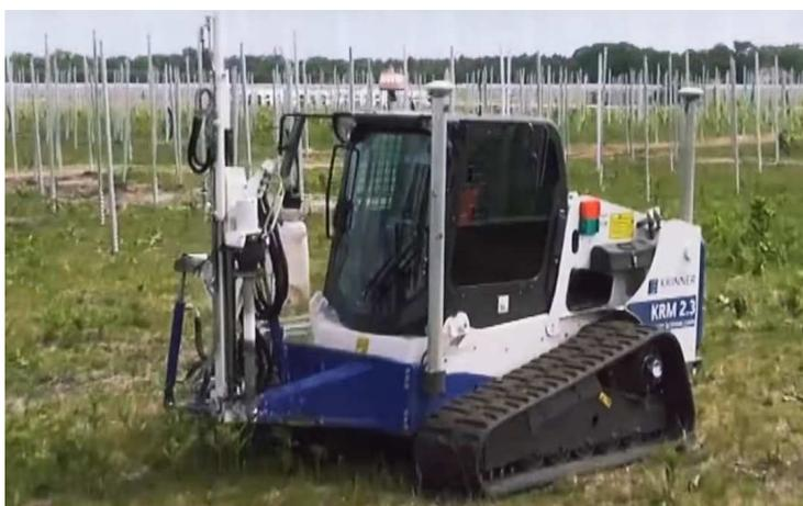
Fig. 42. Esempio di fissaggio delle strutture di supporto
