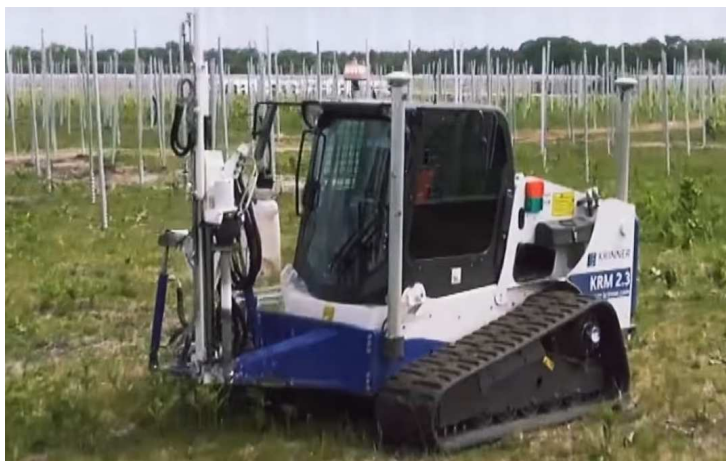
Figura 97. Esempio di fissaggio delle strutture di supporto
