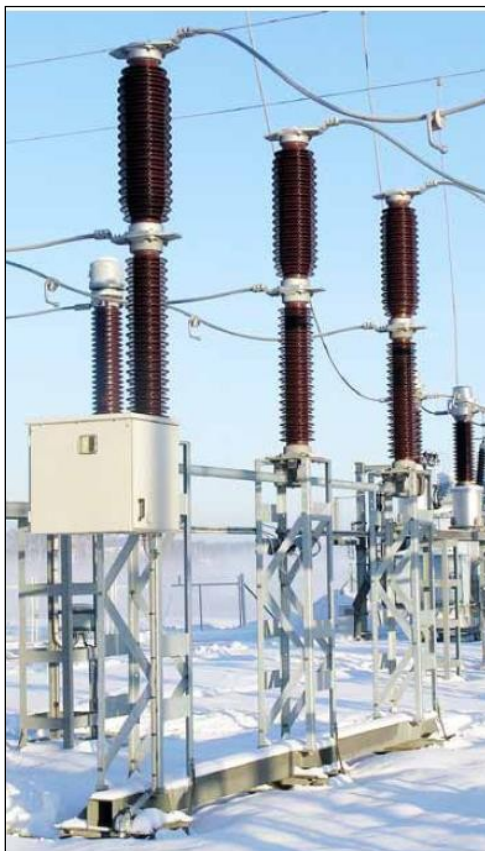
Fig. 15. Particolare Interruttore con TA incorporato.
