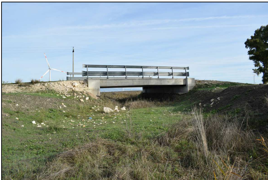
Foto n. 4 – ponticello attraversamento su reticolo idrografico (Canale Macchia Rotonda)
