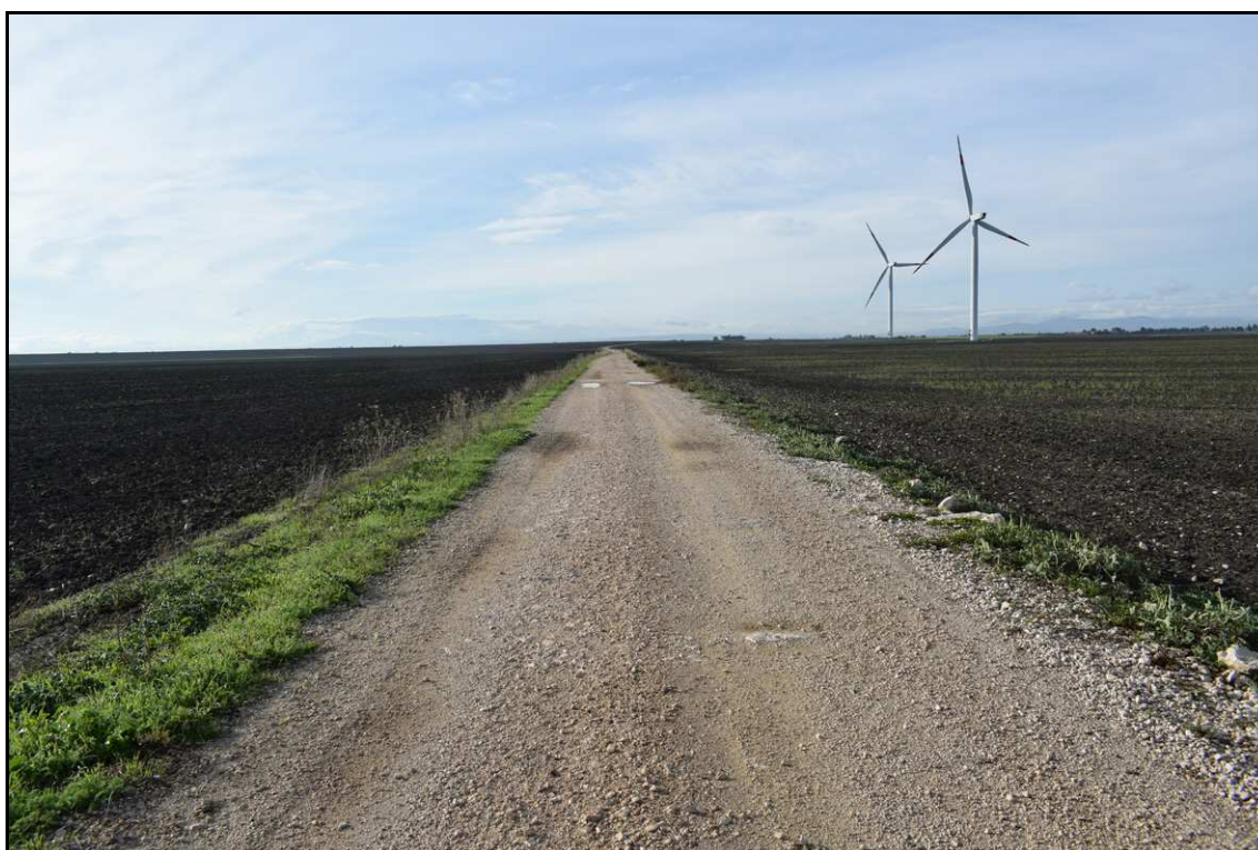
Foto n. 2 – strada brecciata lungo la quale sarà posizionato il cavidotto
