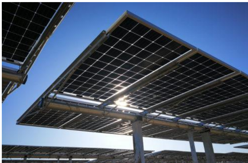
Figura 3.3 Esempio di struttura a tracker monoassiale
