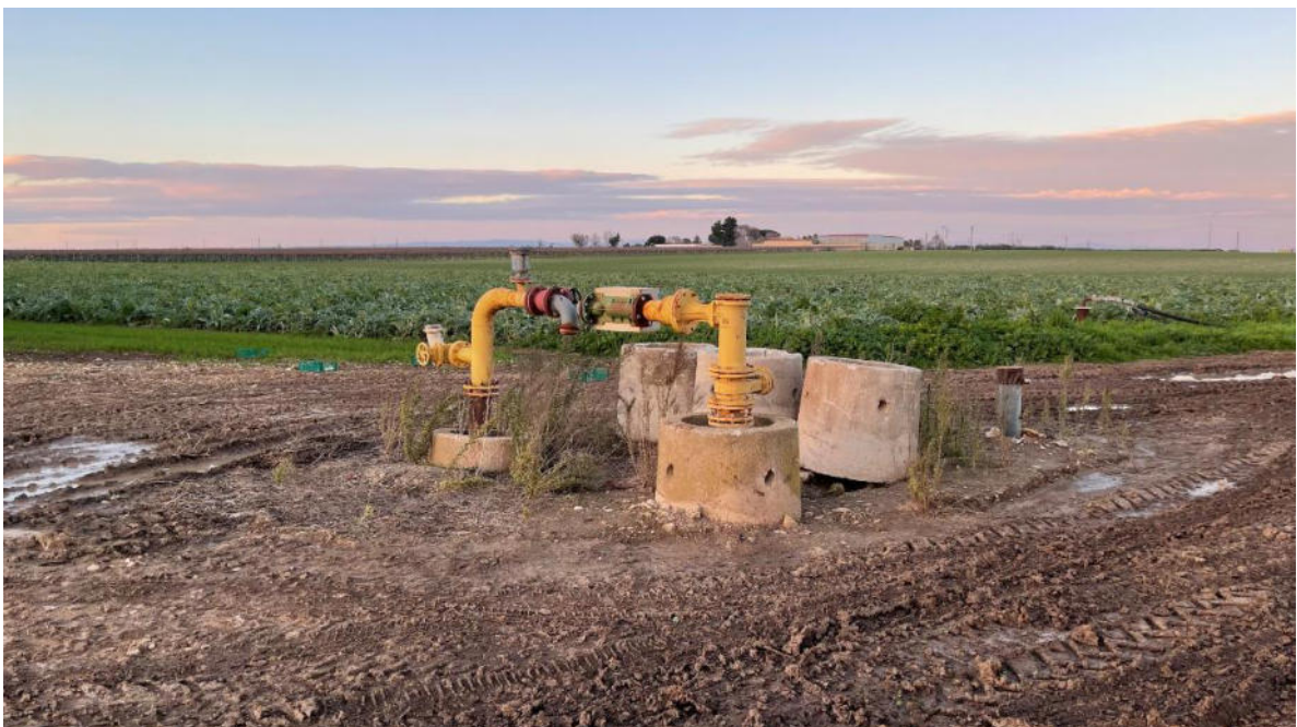
Figura 2.5: Manufatti Idraulici in Sito
