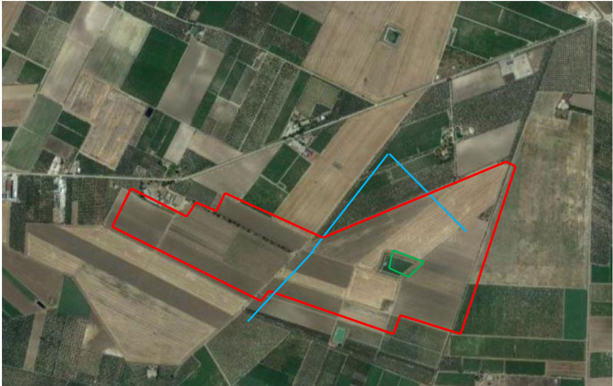
Figura 3.1: Vista satellitare area di intervento
