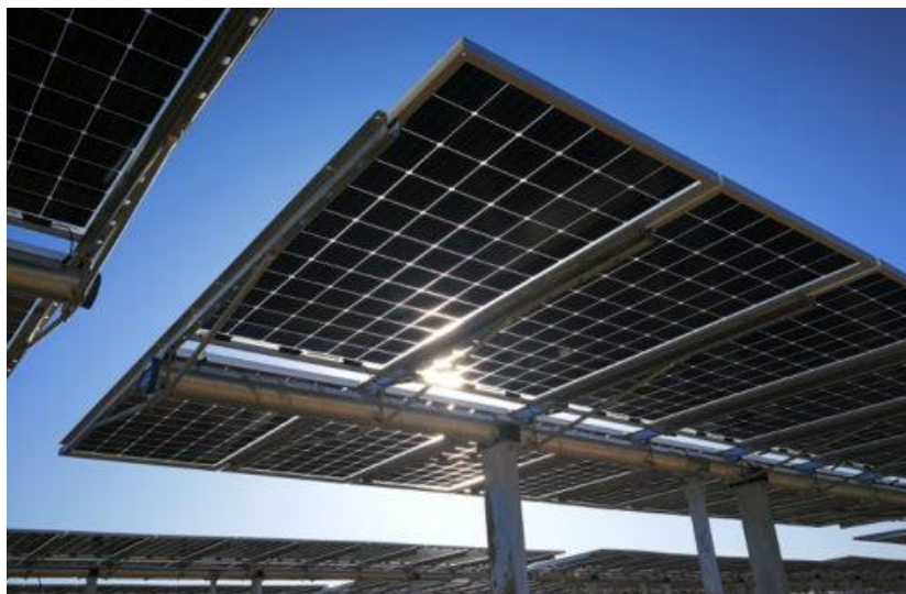
Figura 3.2: Esempio di struttura a tracker monoassiale.
