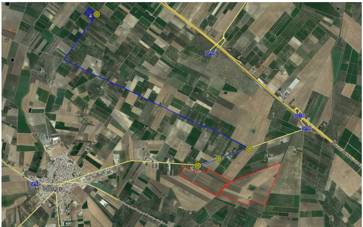
Figura 1.2: Punti di presa fotografica linea di connessione e Sottostazione Elettrica
