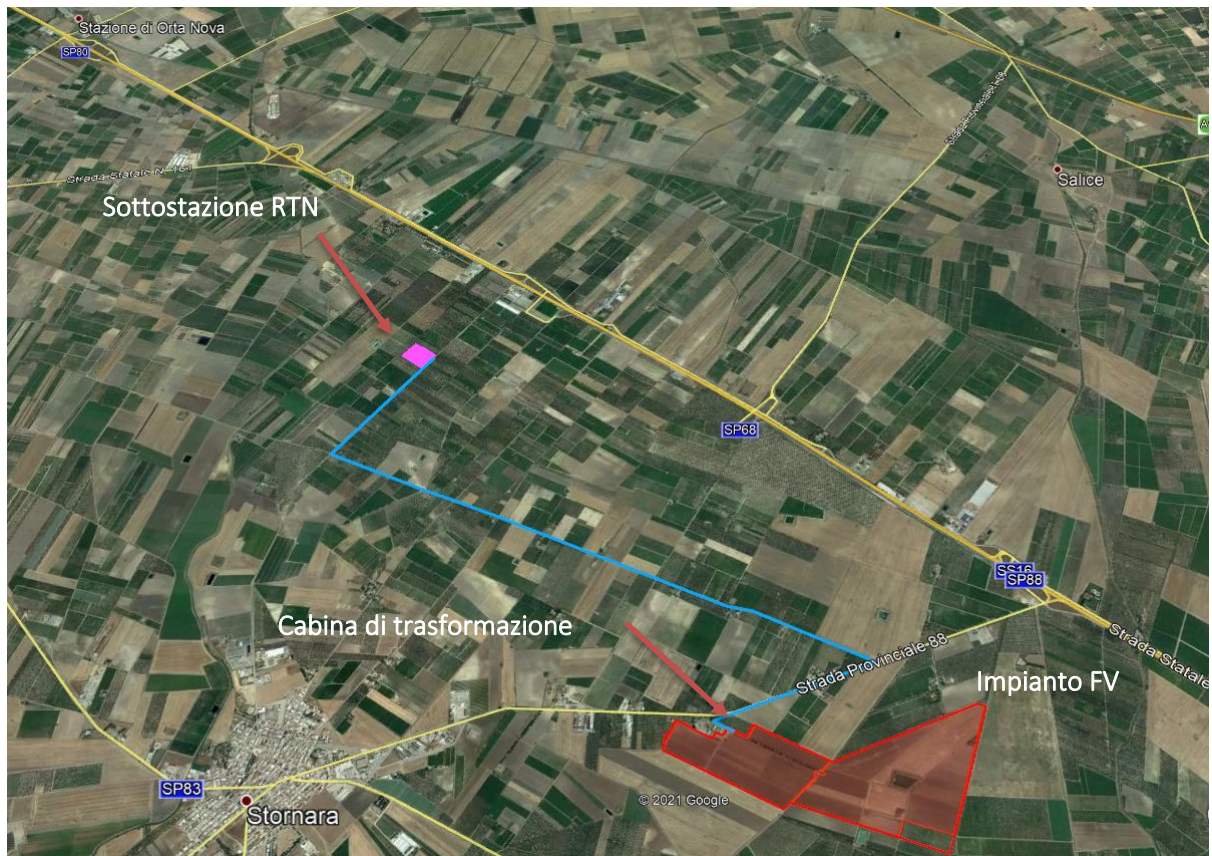
Figura 2.15. percorso di connessione dalla cabina di trasformazione alla Sottostazione AT di Stornara
