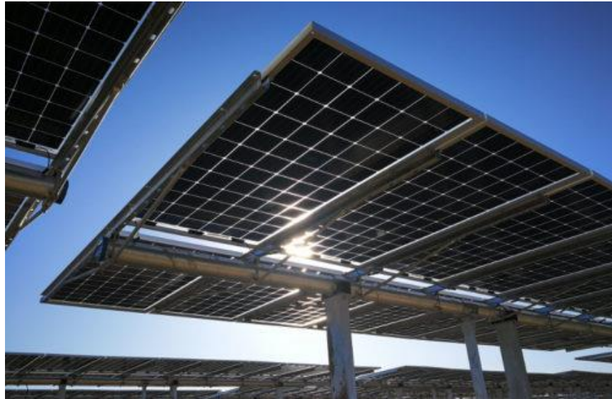
Figura 2.11: Esempio di struttura tipo tracker monoassiale
