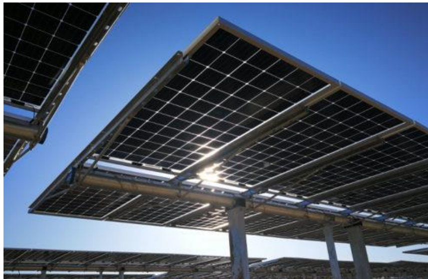
Figura 2.38: Esempio di struttura tipo tracker monoassiale
