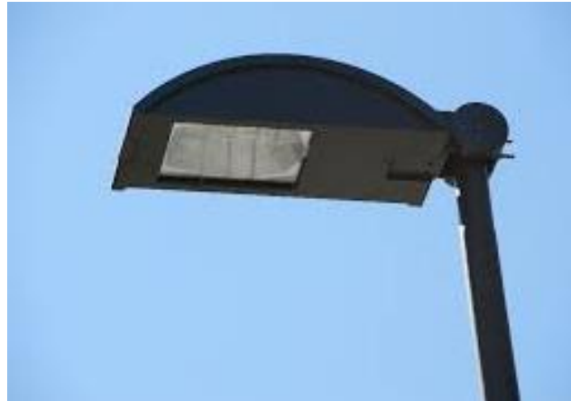
Figura 4.33: Esempio di apparecchio completamente schermato (full-cut-off).
