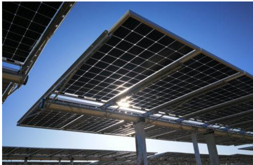
Figura 2.11: Esempio di struttura tipo tracker monoassiale
