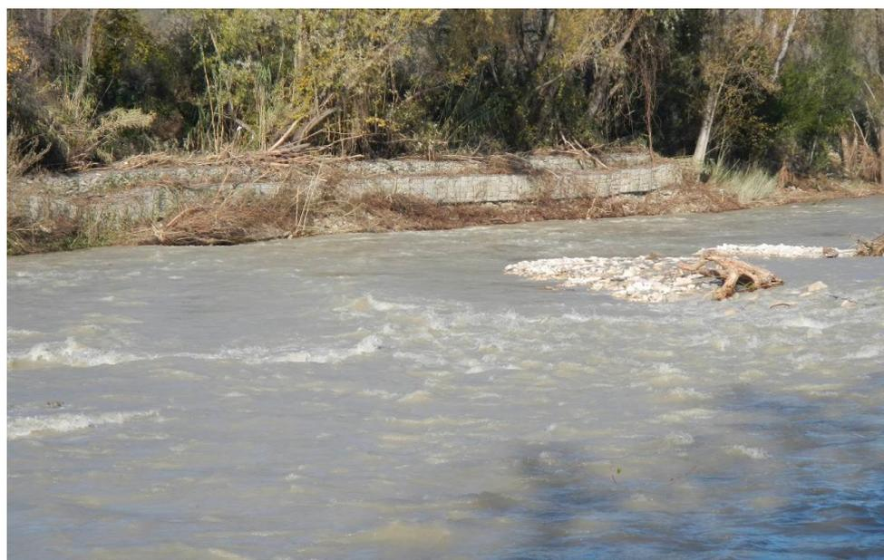
**Figura 7.8 Fiume Pescara subito a valle del ponte di Rosciano (coord.: 4683894.7 N, 2440801.1 E): argini artificiali in gabbioni**
