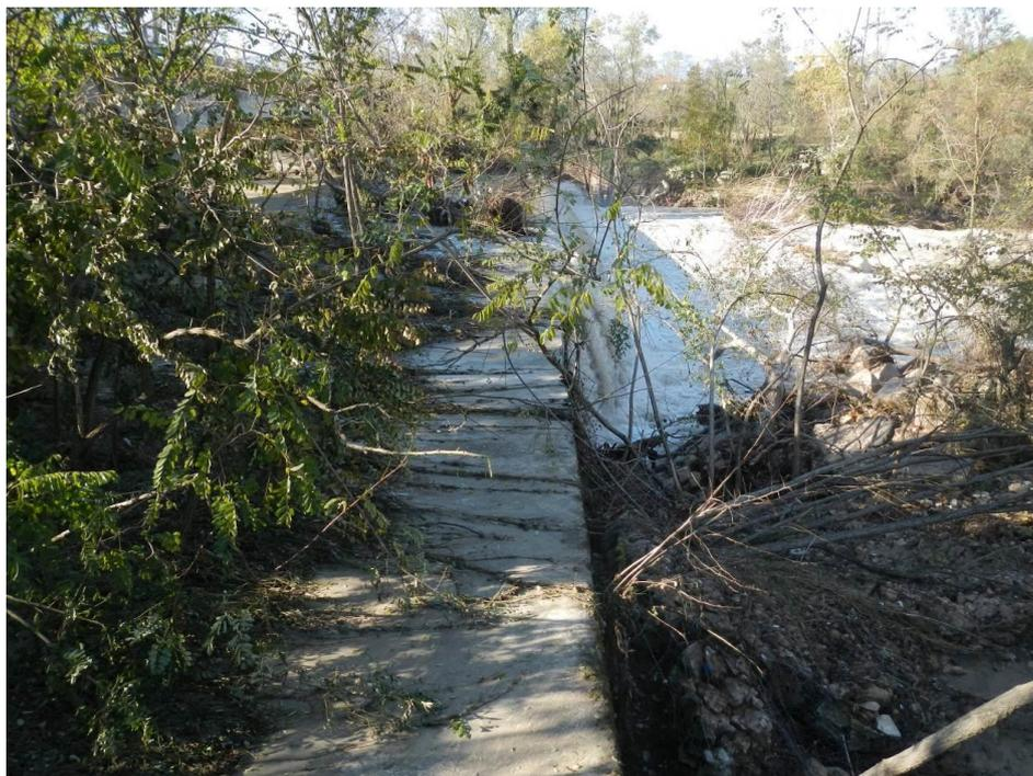
**Figura 7.7 Fiume Pescara subito a valle del ponte di Rosciano (coord.: 4683849.5 N, 2440820.9 E): briglia in cemento armato con salto fluviale di circa 3 metri**
