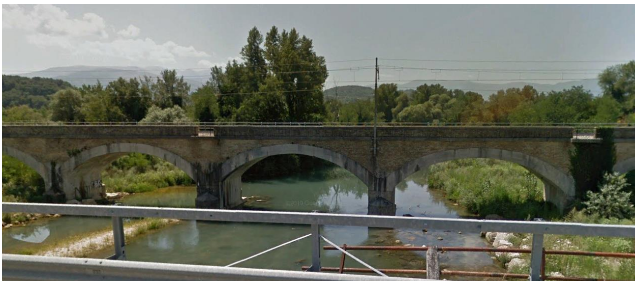
Figura 5 – Fiume Pescara: prospetto (lato valle) dell'opera di attraversamento esistente, in uscita dalla stazione di Manoppello.
