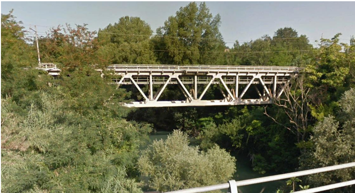
Figura 7 – Fiume Pescara: prospetto (lato valle) dell'opera di attraversamento esistente, in ingresso alla stazione di Scafa.
