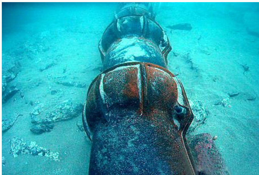
Figura 8.13 Cavo adagiato sul fondo marino e protetto con Cast Iron Shells Installation
