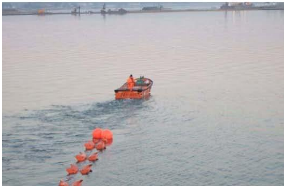
Fig. 11.4 barchini di appoggio durante la fase di posa del cavo in prossimità dell'approdo
