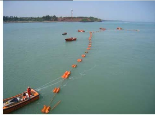
Fig. 11.4 barchini di appoggio durante la fase di posa del cavo in prossimità dell'approdo
