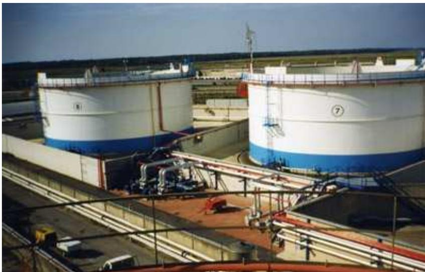
La particolare conformazione planimetrica del sito, in aggiunta alle restrizioni normative, consente l'allocazione di n° 3 serbatoi in acciaio a tetto fisso di diametro interno di 31,00 m (capacità 5.300 m<sup>3</sup> cadauno) e di un serbatoio di diametro interno di 22,00 m (capacità 2.600 m<sup>3</sup>). L'altezza al colmo dei serbatoi è posta a m 8,50;
