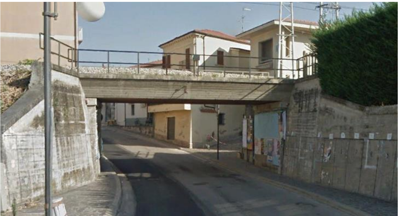
Fig. 36 – VI25 – Ponte esistente su Corso Primo Maggio
