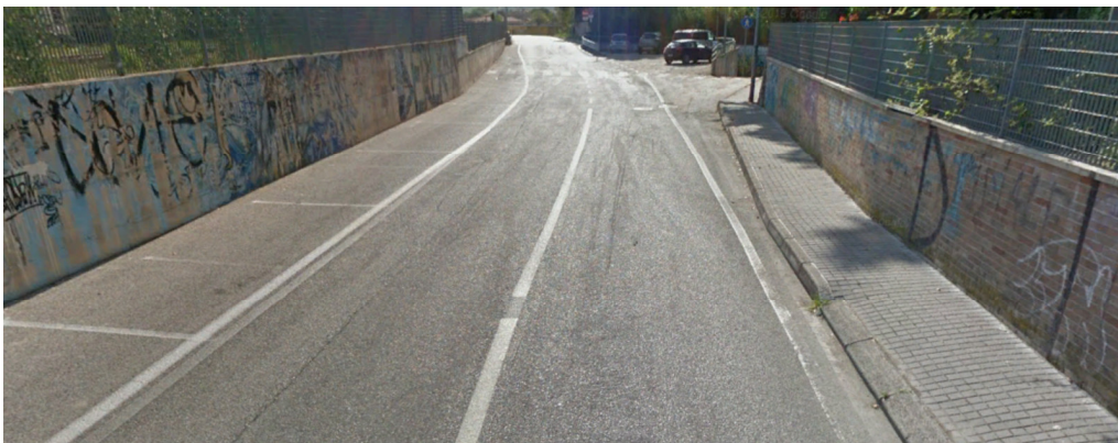
Fig. 3833 –NV26- Stato attuale
