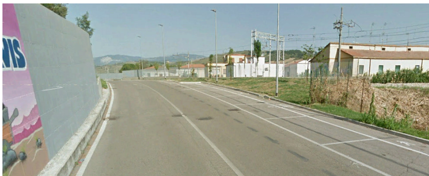
Fig. 39 –NV26- Stato attuale
