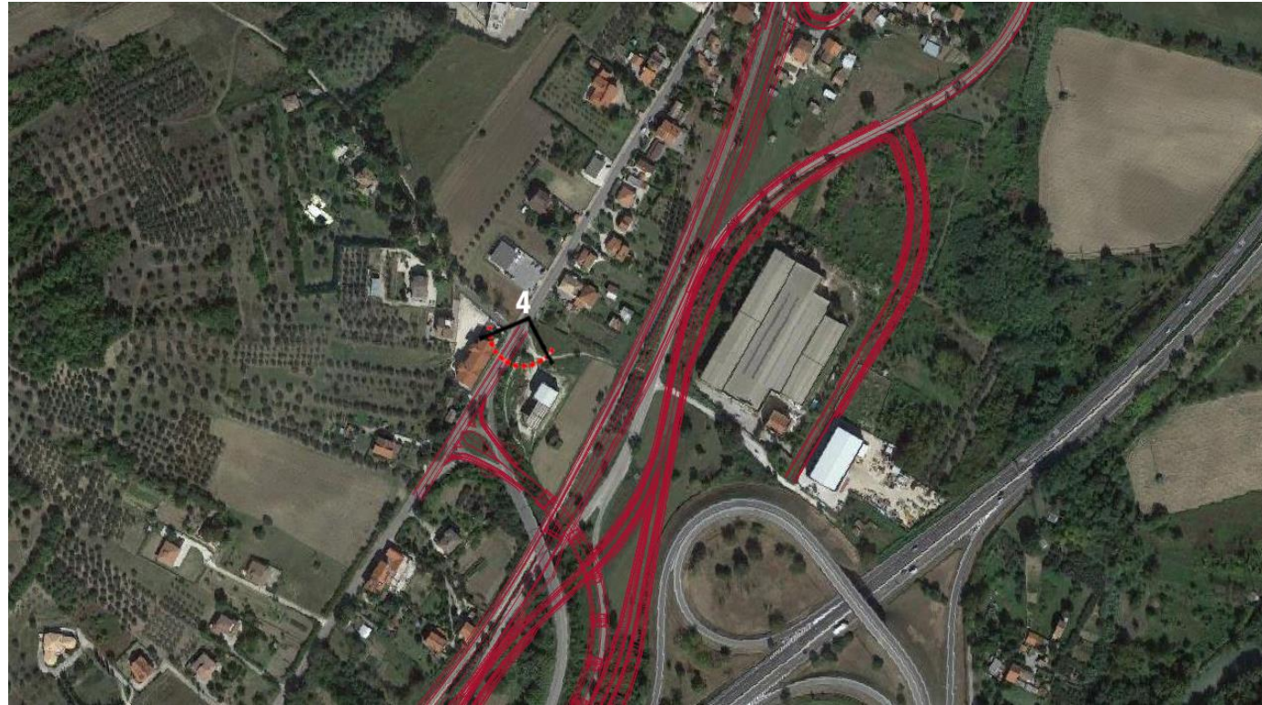
Inquadramento intervento di inserimento di barriere antirumore all'altezza della pkm 5+500, all'interno del territorio di Alanno (frazione Alanno scalo), punto di vista da Via S. Cassiano.
