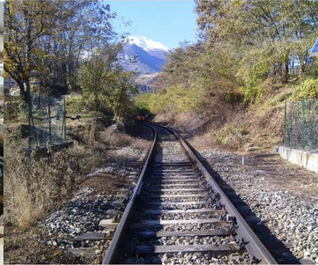
Impianto lubrificazione P.A.L. Italia (Foto: P.A.L. Italia; 2012)
