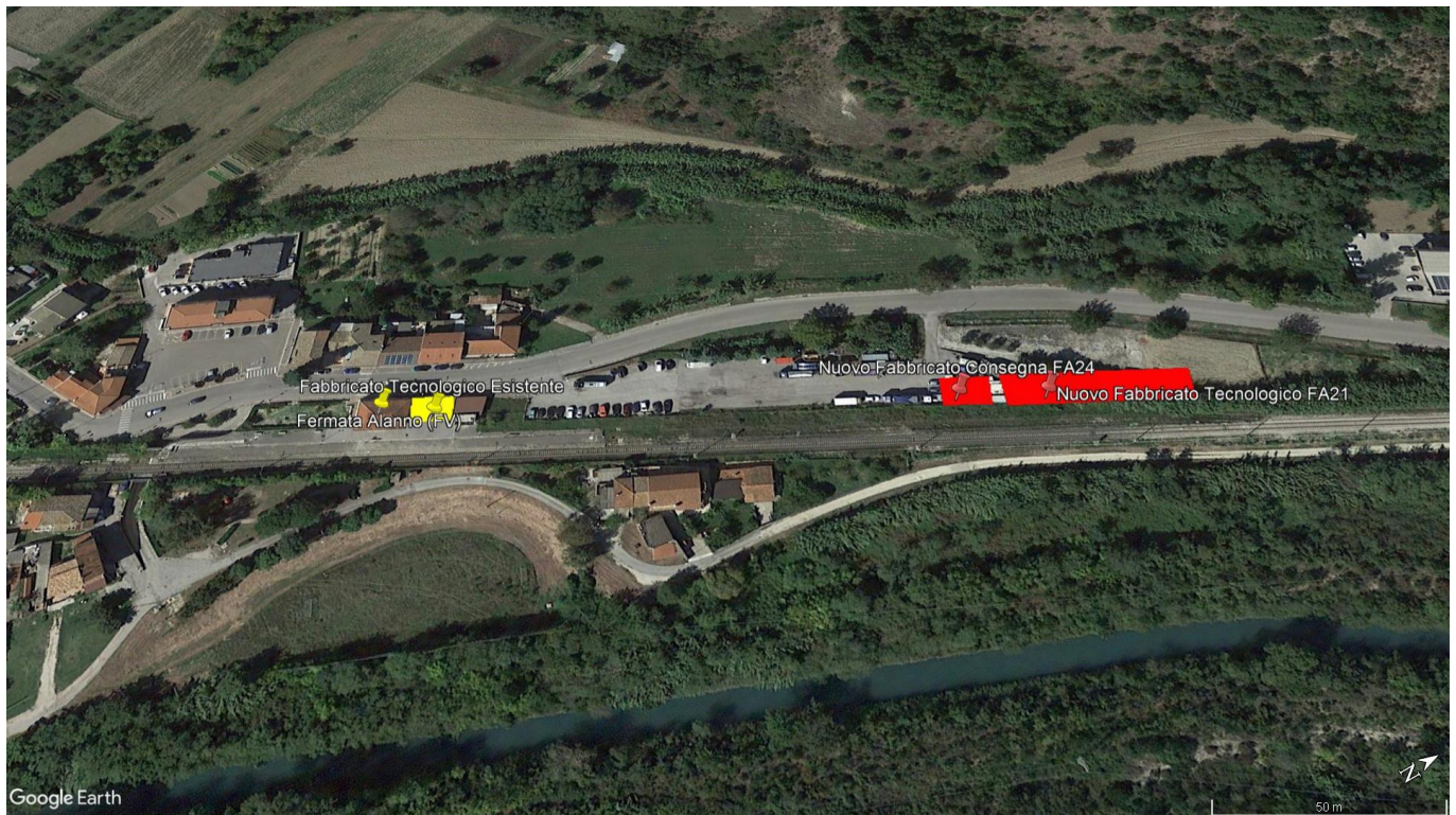
Figura 1 –Stazione di Alanno - Localizzazione Fabbricati Tecnologici
