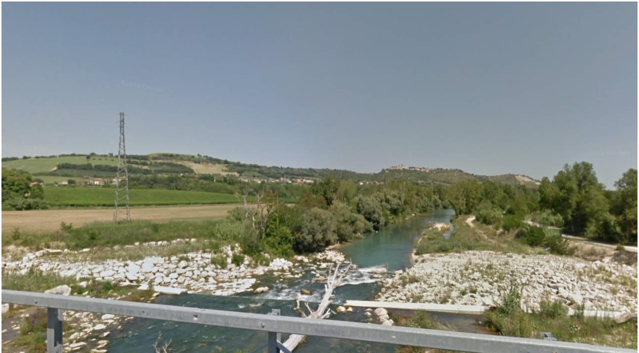
FIGURA 22 ATTRAVERSAMENTO DEL FIUME PESCARA, PONTE DI ROSCIANO, IN DIREZIONE NORD
