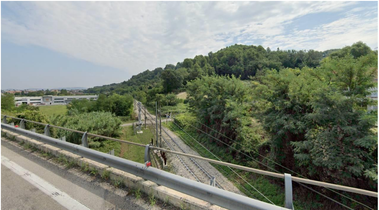
FIGURA 20 SOVRAPPASSO FERROVIARIO LUNGO LA SR 5, MANOPPELLO, IN DIREZIONE EST
