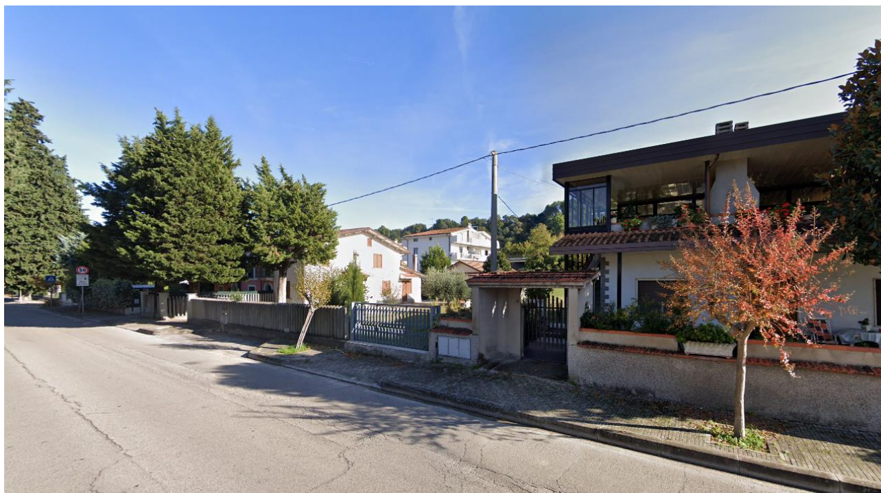
FIGURA 68 FRONTE EDIFICATO LUNGO VIA GIACOMO MATTEOTTI, ALTEZZA VIA TIRINO, MANOPPELLO SCALO
