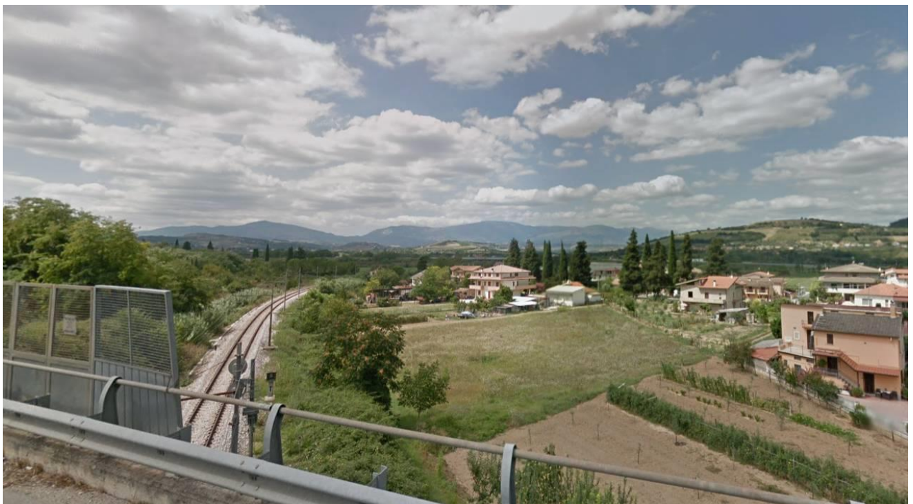
FIGURA 19 SOVRAPPASSO FERROVIARIO LUNGO LA SR 5, MANOPPELLO, IN DIREZIONE OVEST
