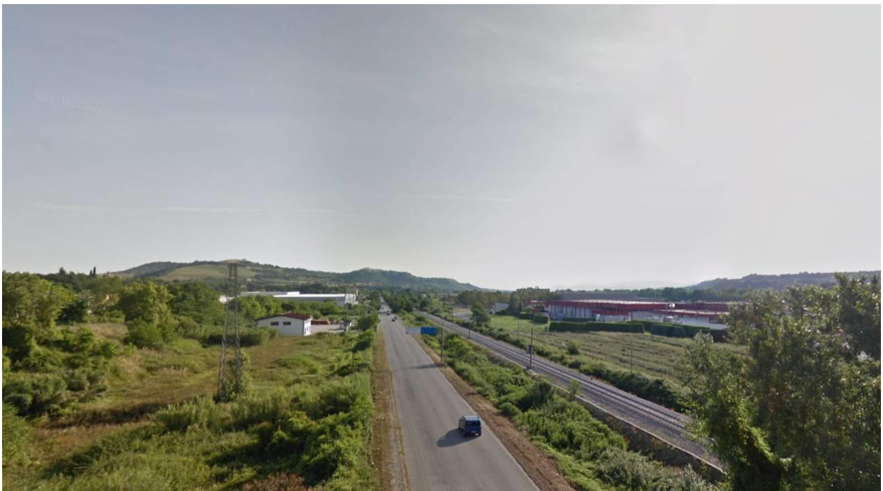
FIGURA 23 SOVRAPPASSO FERROVIARIO DA DEMOLIRE LUNGO VIALE DEL LAVORO, ALANNO ZONA INDUSTRIALE
