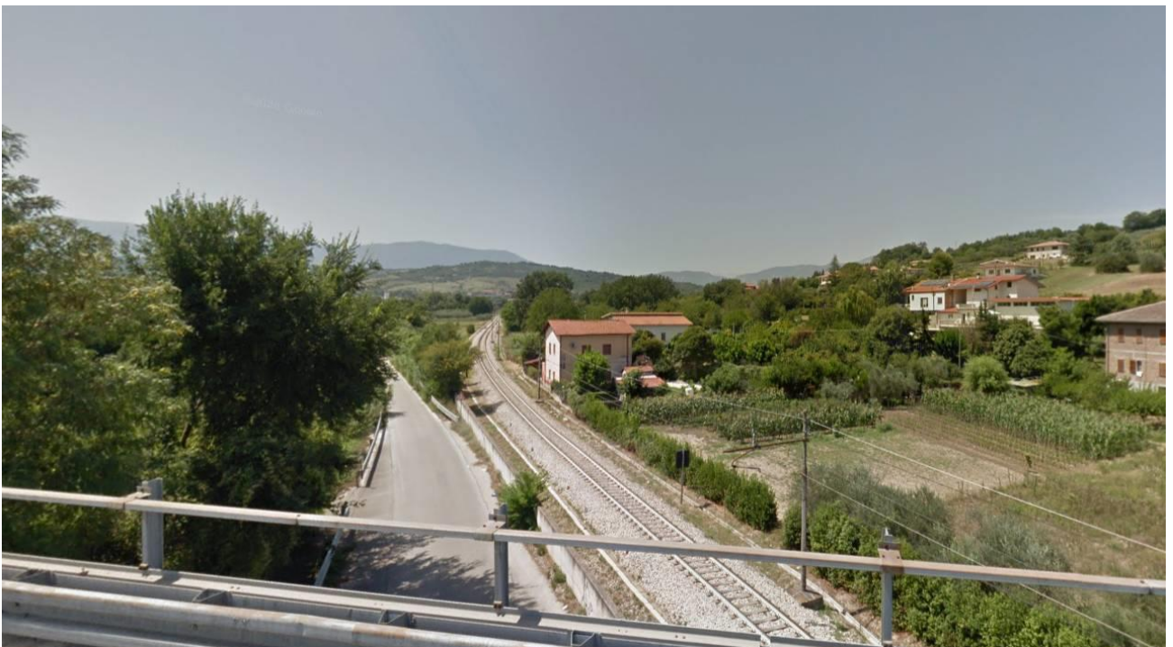
FIGURA 25 ATTRAVERSAMENTO FERROVIARIO SU VIA FIUME PESCARA, ALANNO, IN DIREZIONE SUD
