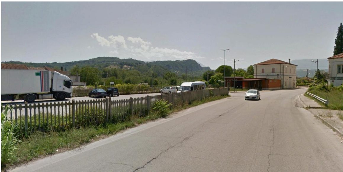
Figura 1: Stazione di Alanno Ante-operam
