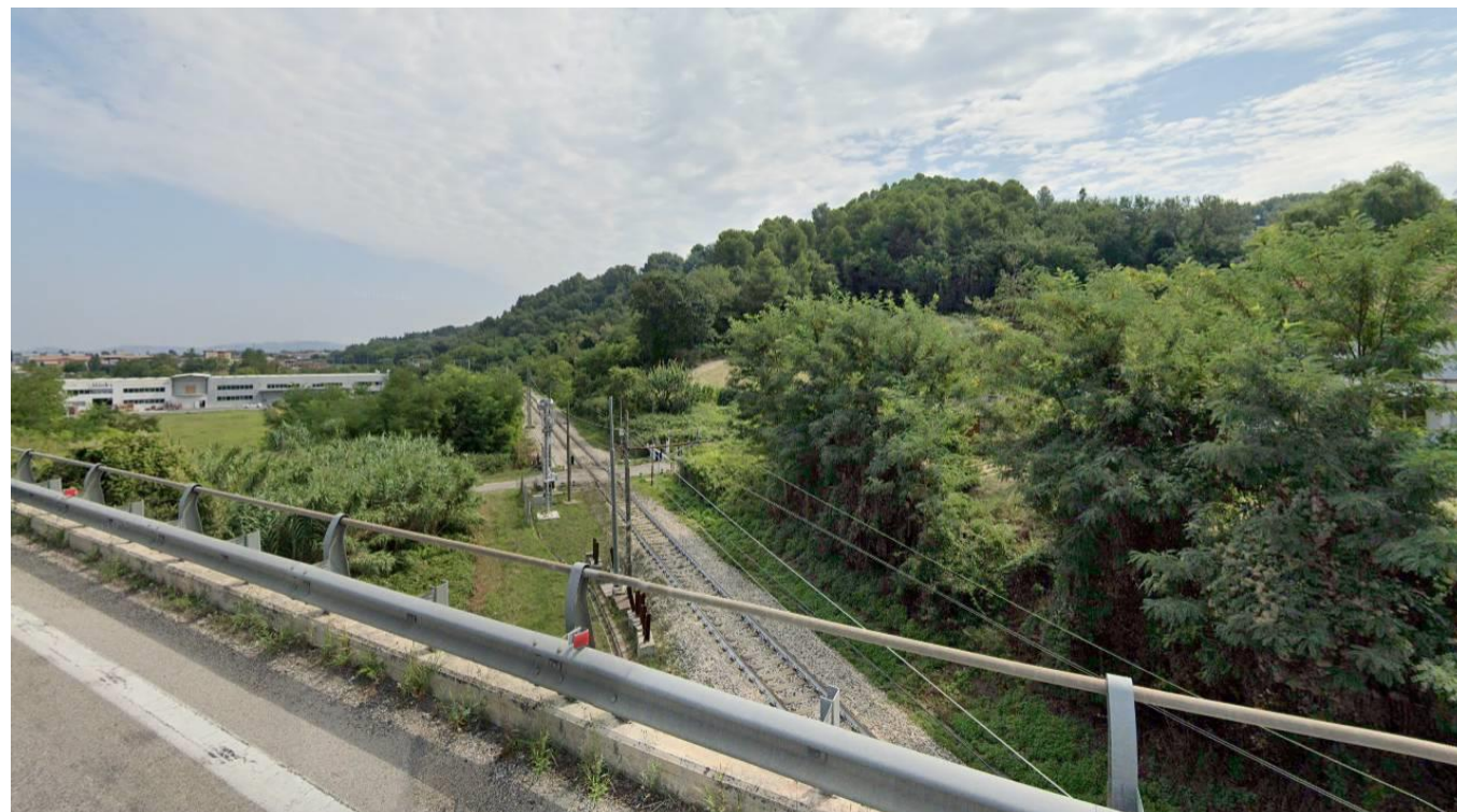
FIGURA 46 SOVRAPPASSO FERROVIARIO LUNGO LA SR 5, MANOPPELLO, IN DIREZIONE EST
