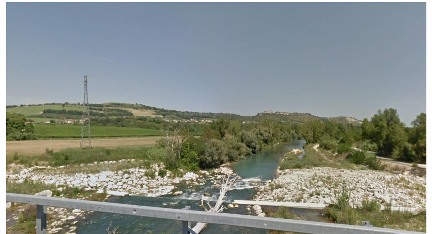
FIGURA 48 ATTRAVERSAMENTO DEL FIUME PESCARA, PONTE DI ROSCIANO, IN DIREZIONE NORD
