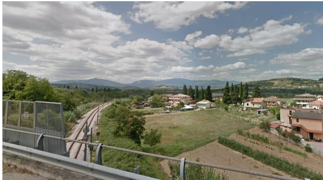
FIGURA 45 SOVRAPPASSO FERROVIARIO LUNGO LA SR 5, MANOPPELLO, IN DIREZIONE OVEST
