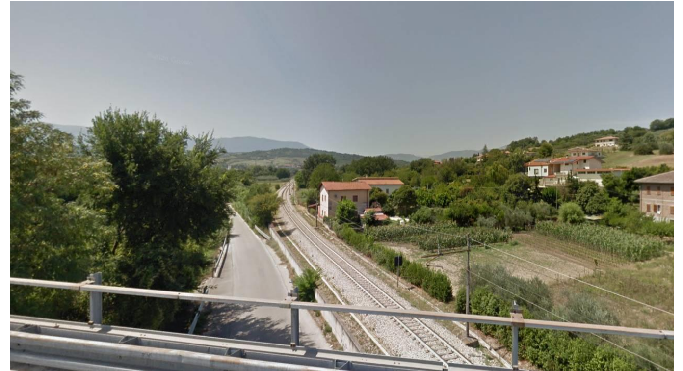
FIGURA 51 ATTRAVERSAMENTO FERROVIARIO SU VIA FIUME PESCARA, ALANNO, IN DIREZIONE SUD
