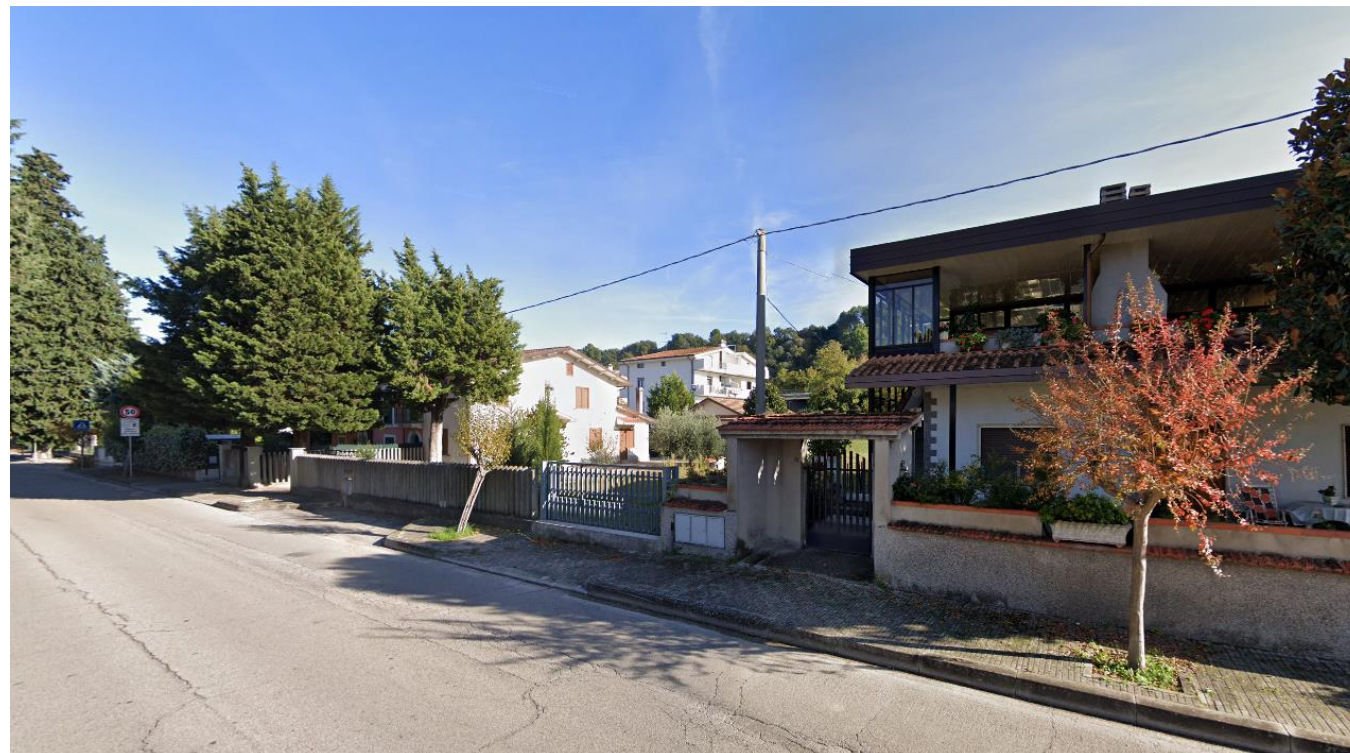
FIGURA 70 FRONTE EDIFICATO LUNGO VIA GIACOMO MATTEOTTI, ALTEZZA VIA TIRINO, MANOPPELLO SCALO
