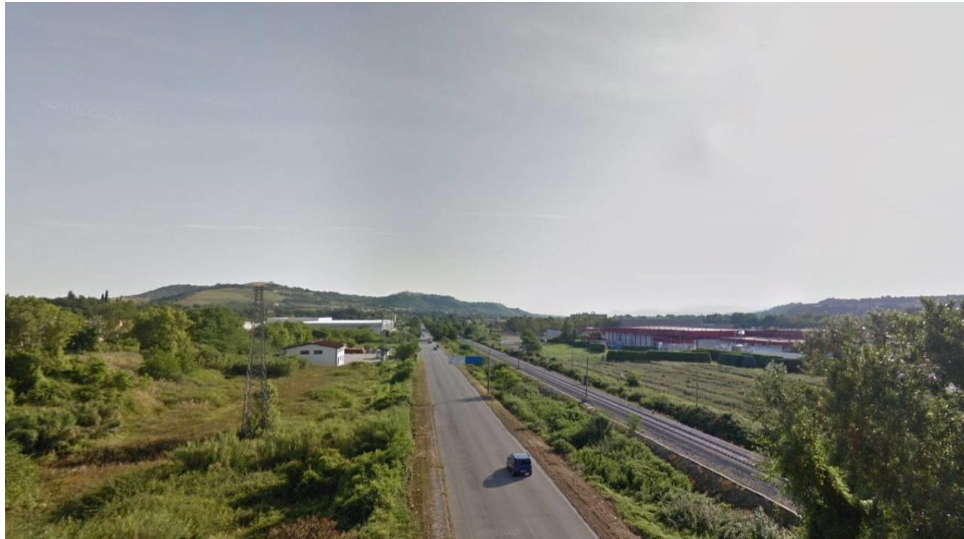
FIGURA 49 SOVRAPPASSO FERROVIARIO DA DEMOLIRE LUNGO VIALE DEL LAVORO, ALANNO ZONA INDUSTRIALE
