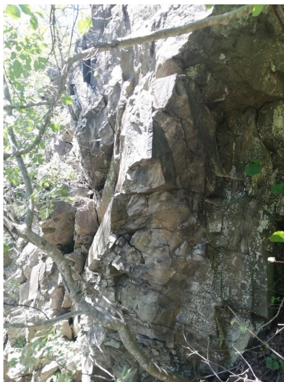
Figura 2-5. Affioramento roccioso fratturato; questa zona è stata successivamente modellata come area di distacco (Soil Type 6).
