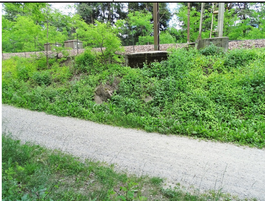
Figura 2-8. Pista ciclabile con fondo sterrato che corre al piede del versante parallela alla ferrovia e ballast ferroviario (Soil Type 3).
