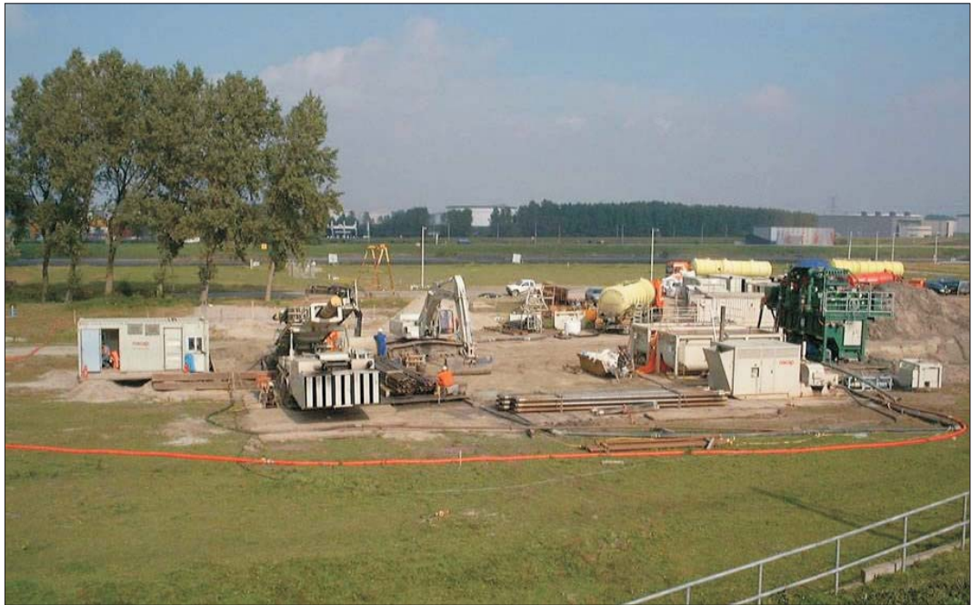
IMMAGINE DI UN CANTIERE A TERRA
