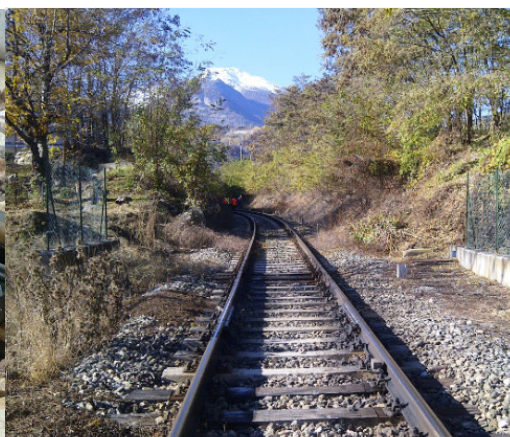
Impianto lubrificazione P.A.L. Italia (Foto: P.A.L. Italia; 2012)
