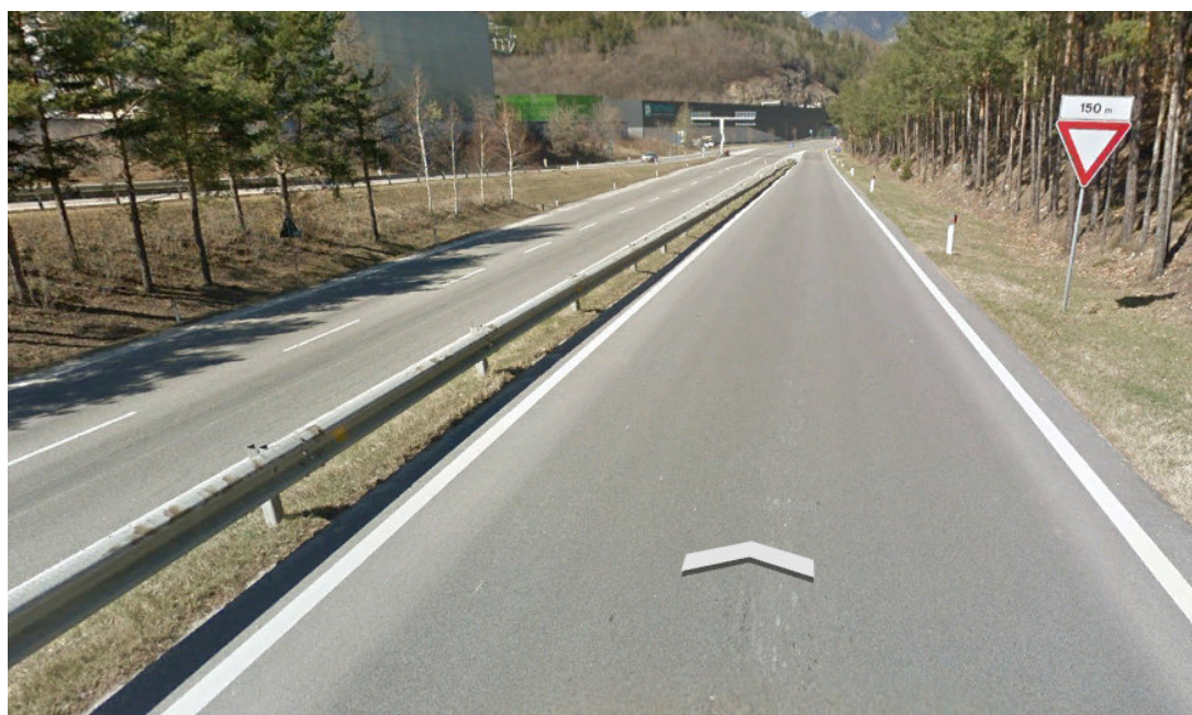
Rampa di accesso alla SS.12 dir. Nord
