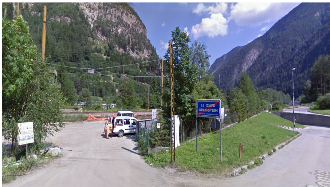
Accesso al cantiere armamento
