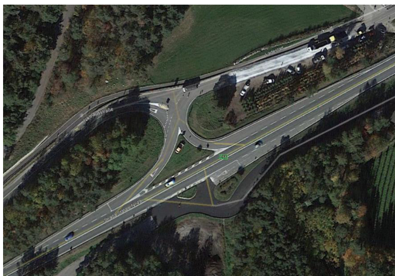
Stato di fatto nell'intorno dell'area oggetto degli interventi NV02
