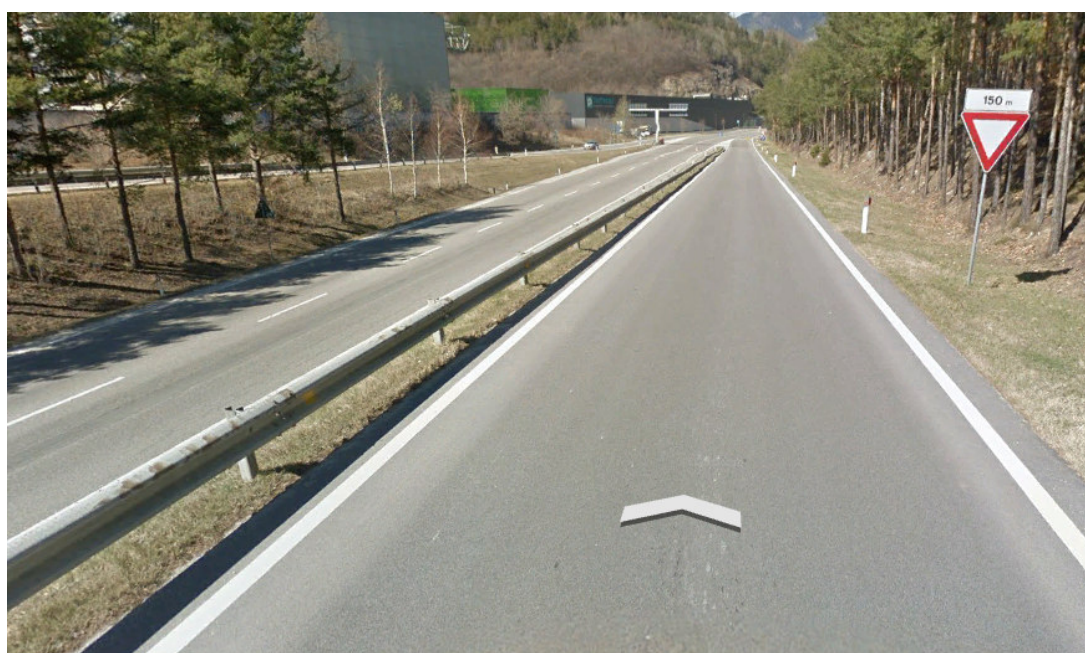
Rampa di accesso alla SS.12 dir. Nord
