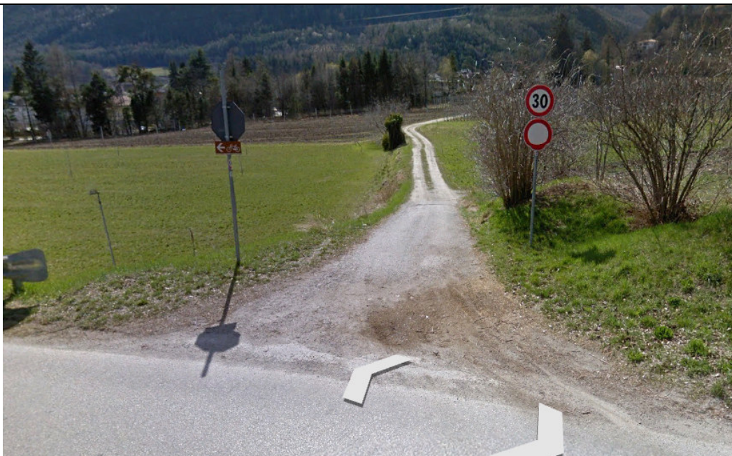
Inizio viabilità di cantiere
