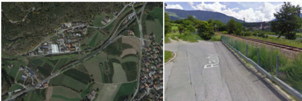
GA06 – Vista aerea della zona e localizzazione dell'intervento dal lato del binario esistente
