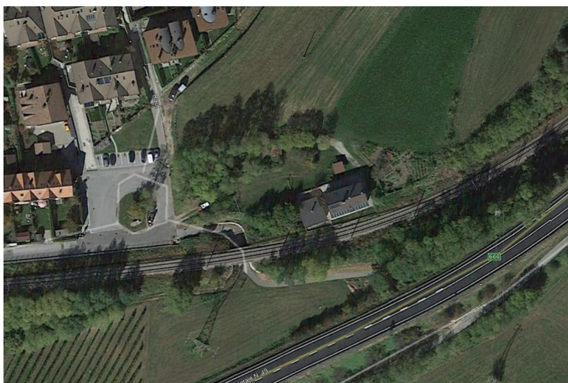
Stato di fatto nell'intorno dell'area oggetto degli interventi NV03
