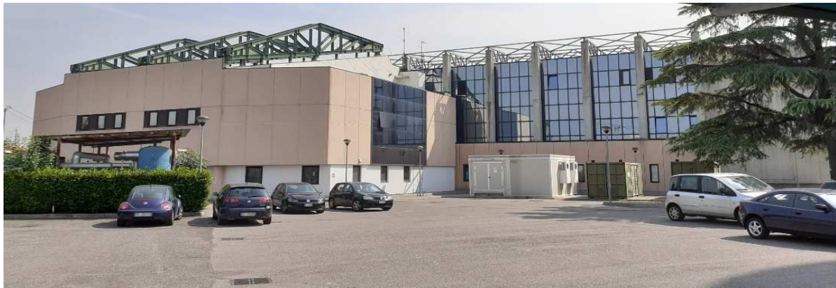
Figura 1 – Fabbricato attuale Posto Centrale SCC Verona
