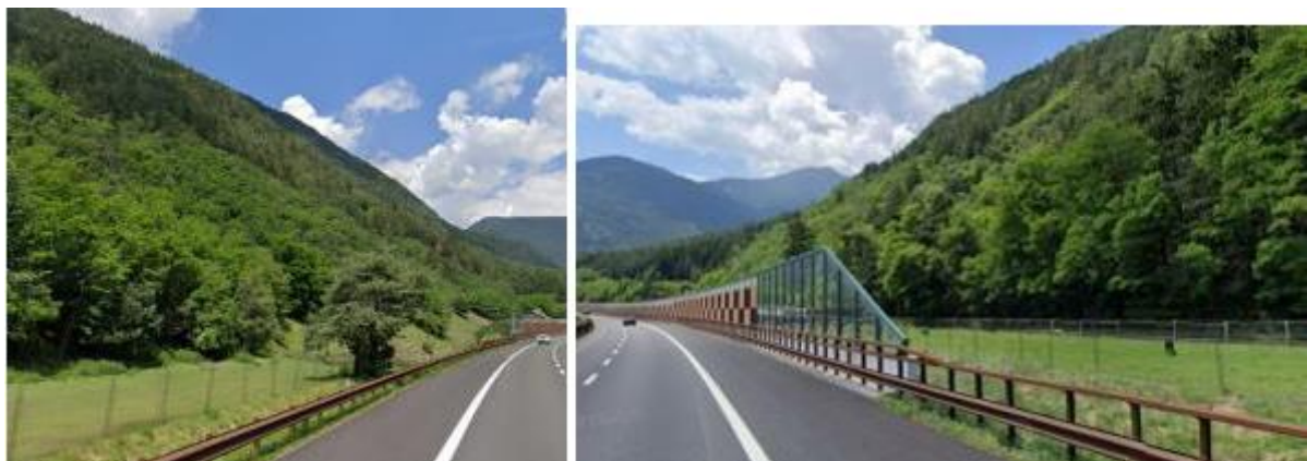
Figura 5-16 Vista dall'autostrada A22, in direzione della linea ferroviaria esistente.
