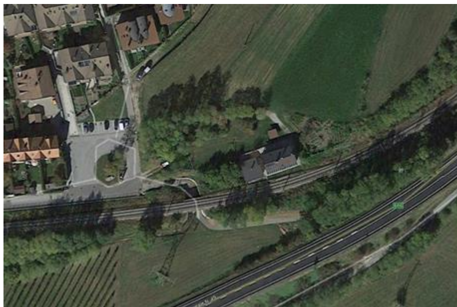
Figura 2-12 Stato di fatto nell'intorno dell'area oggetto degli interventi NV03
