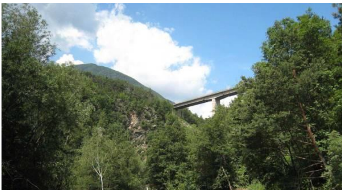
Figura 4-31 Il tratto di gola nella Val Riga di dentro, sovrastato dal ponte della strada statale della Val Pusteria.
