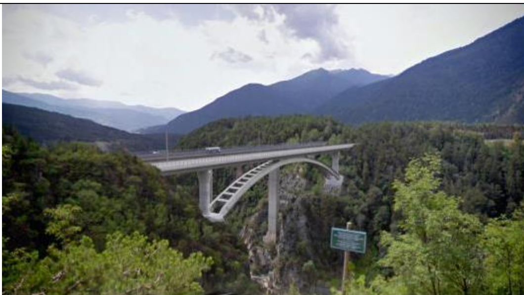
Figura 5-17 Situazione ante e post operam –Nuovo Viadotto VI01 in corrispondenza dell’attraversamento del fiume Isarco.
