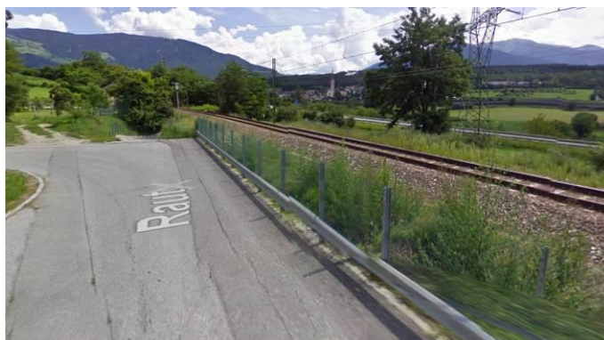
Figura 27 - Vista aerea della zona e localizzazione dell’intervento dal lato del binario esistente
