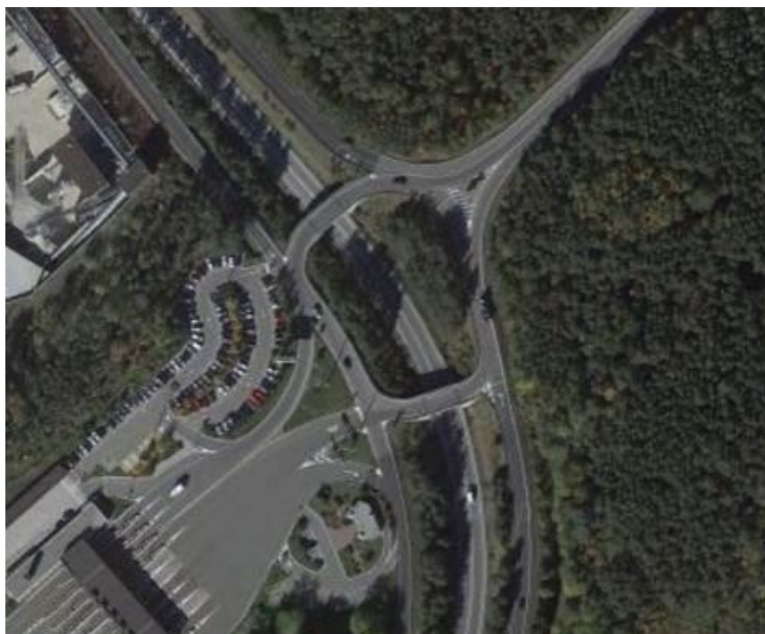
Figura 16 – Vista aerea zona di intervento
