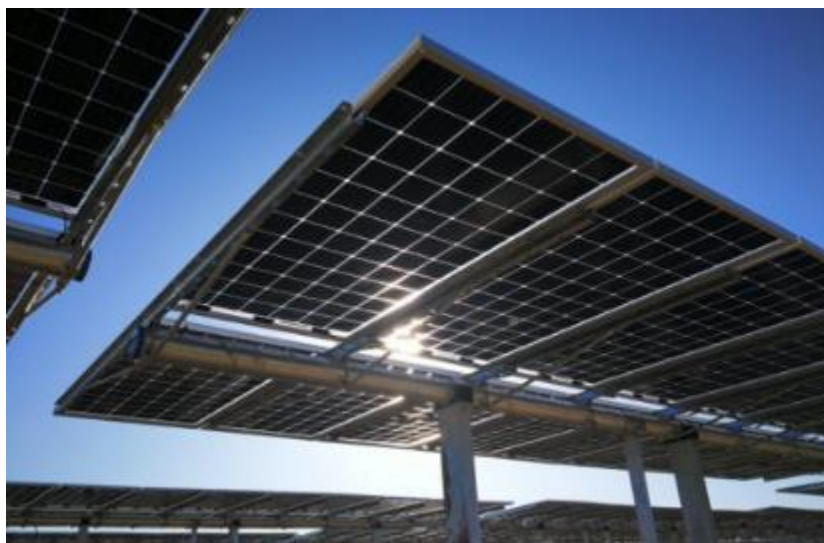
Figura 3.5 Esempio di struttura a tracker monoassiale
