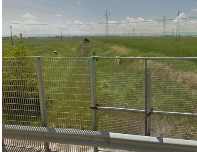
Figura 5-37: Stato di fatto – vista verso valle
