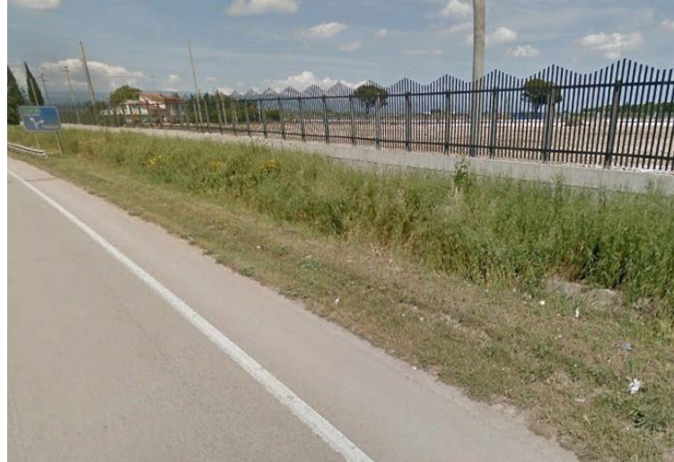
Figura 5-32: Stato di fatto
