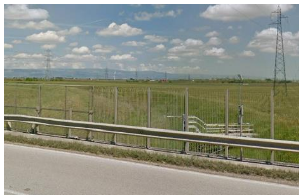
Figura 5-36: Stato di fatto – vista verso monte
