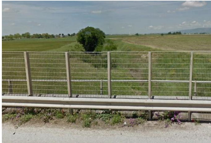
Figura 5-41: Stato di fatto
