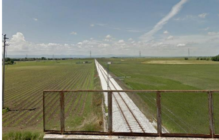
Figura 5-28: Stato di fatto – vista linea ferroviaria attraversata
