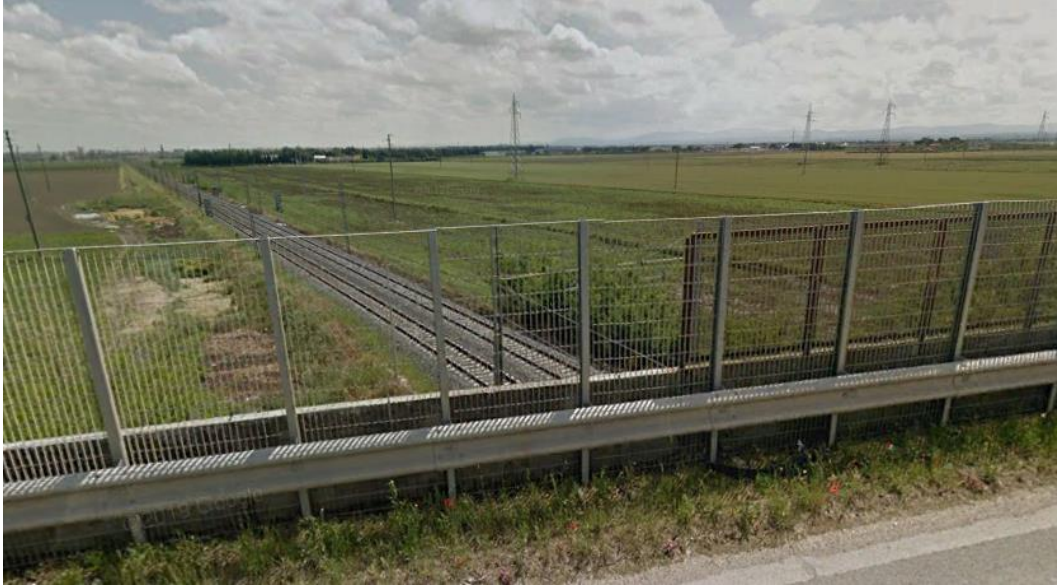
Figura 5-46: Stato di fatto – vista linea ferroviaria attraversata
