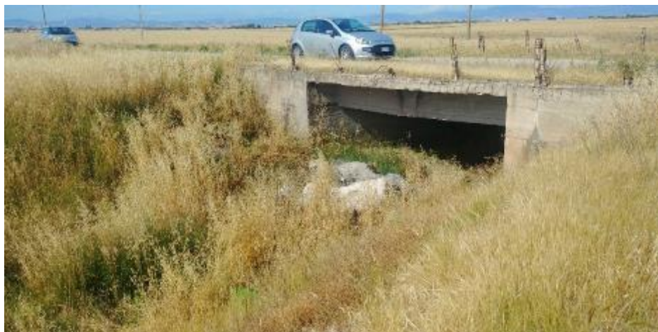
Figura 2.4: Attraversamento Torrente Laccio – punto 4
