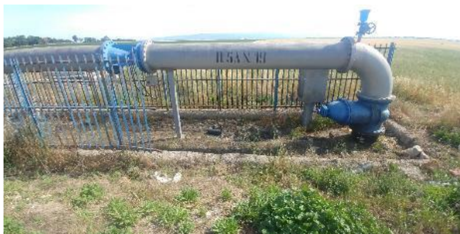
Figura 2.6: Condotta secondaria consorzio – punto 7
